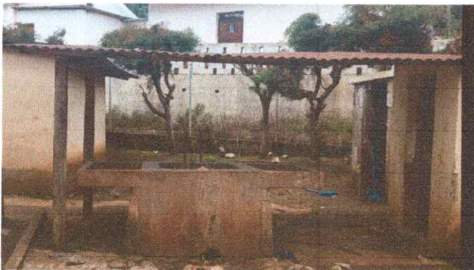
Foto 15: Sustrucción de pila de cemento de dos lavadero
