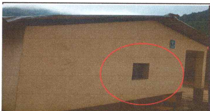
Foto 6: Sustrución de ventanas de madera por metal mas vidrio 1Mx1M
