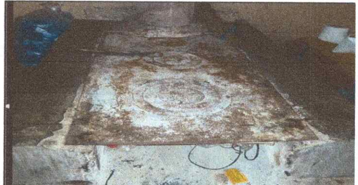
Foto 14: Instalación de azulejo en estufa rural
