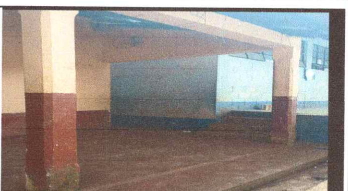
Foto 10: Pintura en muros exteriores e interiores
