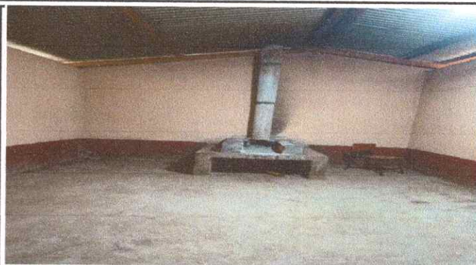
Foto 8: Sustrucción de piso de granito
