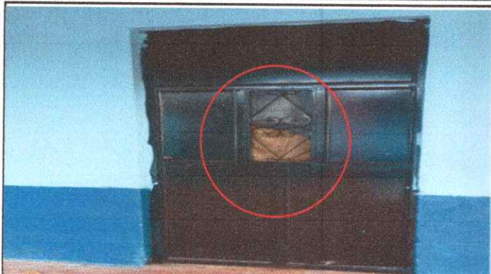
Foto 7: Sustrucción de vidrios
