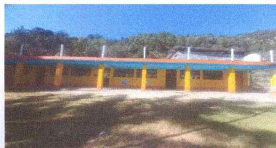
Foto 2: SUSTITUCION DE CHAPAS Y BALCONES
