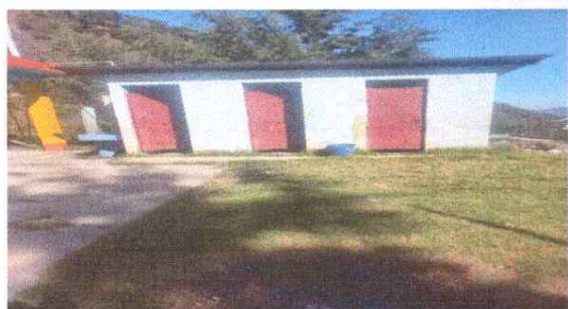
Foto 1: SUSTITUCION CUBIERTA DE LÁMINAS
