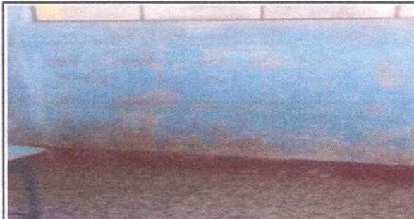
Foto 4: PINTURA EN MUROS INTERIORES Y EXTERIORES
