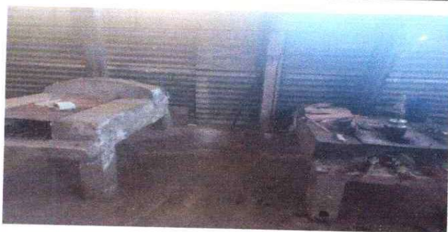
Foto 9: REPARACIÓN DE COCINA
