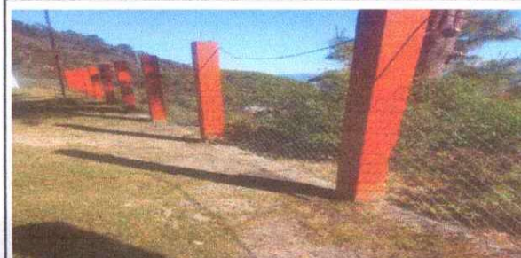
Foto 6: REPARACIÓN DE MURO PERIMETRAL DE MALLA
