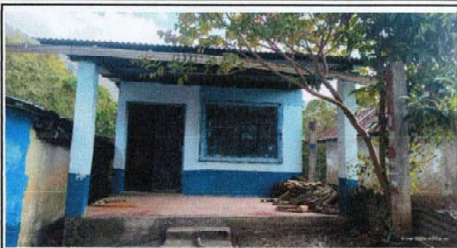
Foto1: Mantenimiento de balcones,cambio de piso y pintado de cocina y aulas.
