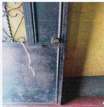
Foto 3: Cambio de chapas.
