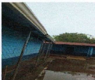
Foto 6: Sustitucion de canal plastico a metal.
