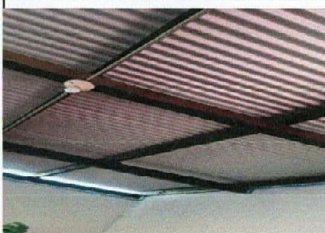
Foto 4: Sustitucion de estructura de soporte de madera por metal.
