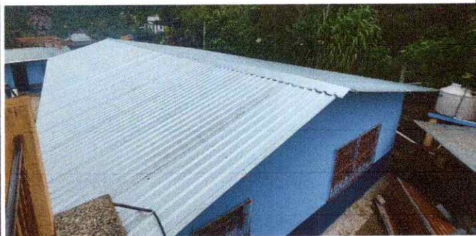
Foto 7: así quedó la sustitución de lámina, por lámina troquelada aluzinc calibre 26, de 187 m2.
