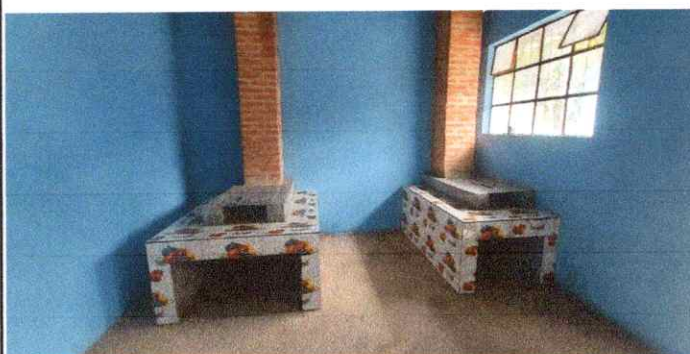
Foto 9: así quedó la sustitución de estufa rural (completa) incluye chimenea de ladrillos, plancha de tres hornillos y base de block.
