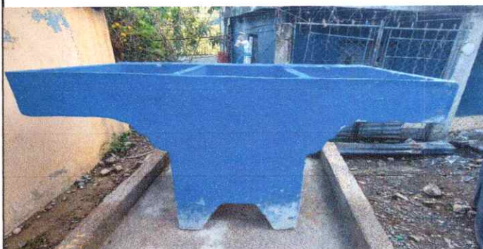
Foto 10: así quedó la sustitución de pila de cemento de dos lavaderos.
