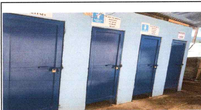
Foto 3: así quedó la sustitución de las 4 puertas nuevas de metal de 175 cm x 65 cm para el servicio sanitario
