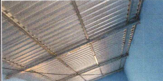
Foto 8: así quedó la sustitución de estructura de soporte de madera, por metal, de 222 ML
