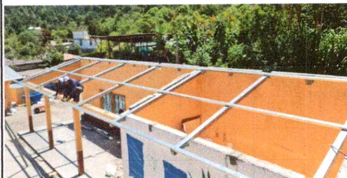
Foto 8. Sustitucion de estructura de soporte de madera, por metal, de 222 ML se encuentra 80 % de avance de trabajo.
