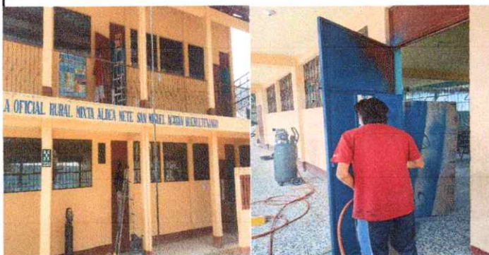
Foto 1: Así se está avanzando el mantenimiento a estructura (lijado, cepillado, sujecciones y aplicación de pinturas a 5 puertas 270 cms altura y 101 cms ancho, 4 puertas 213 cms altura y 93 cms ancho.
