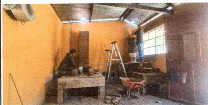
Foto 9: Sustitución de estufa rural (completa) incluye chimenea de ladrillos, plancha de tres hornillos y base de block, con avance 70% de trabajo
