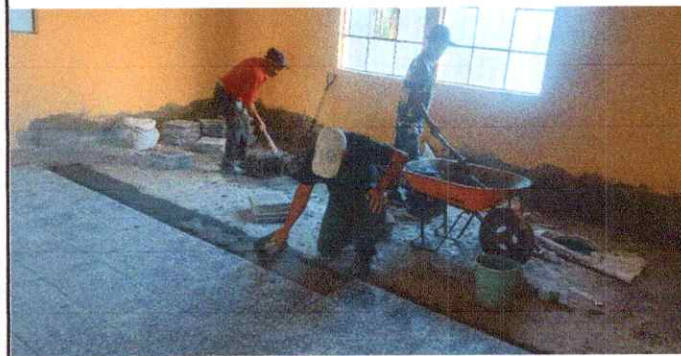
Foto 4: Piso de granito está avanzando con 70%
