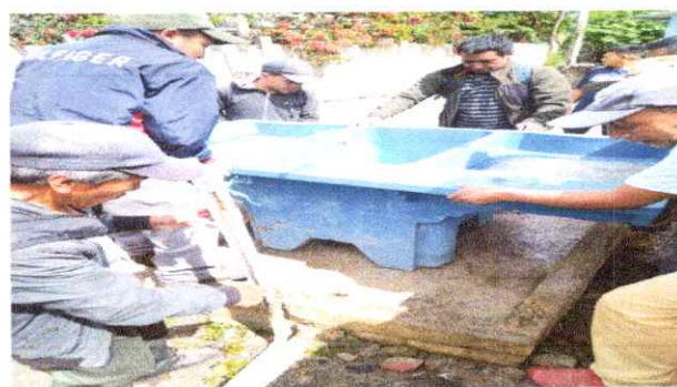
Foto 10: el establecimiento de la sustitución de pila de cemento de dos lavaderos, por los vecinos.
