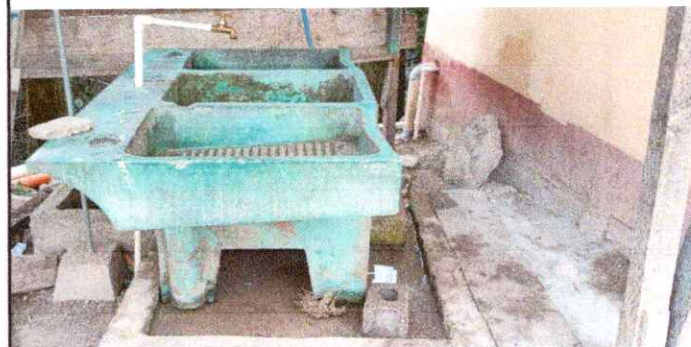
Foto 10: Sustrucción de pila de cemento de dos lavaderos, esta pila se encuentra en mal estado por completo y se necesita una bien establecida para reguardar suficiente agua.
