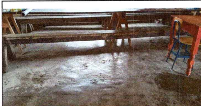
Foto 4: Sustitución de piso de granito, para 105 m2, de dos comedores y la dirección.
