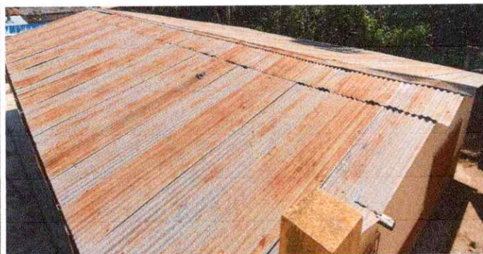
Foto 7: Sustrucción de lámina, por lámina troquelada aluzinc calibre 26, de 187 m2, ya estan occidadas.
