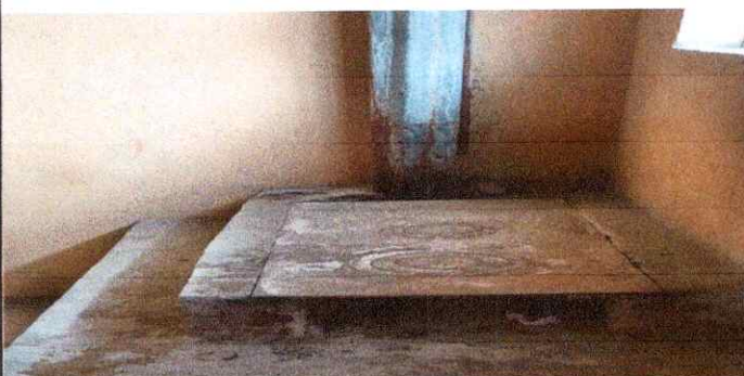
Foto 9: Sustrucción de estufa rural (completa) incluye chimenea de ladrillos, plancha de tres hornillos y base de block, es en mal estado por completo
