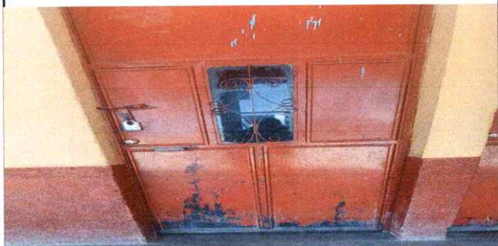
Foto 1: Mantenimiento a estructura (lijado, cepillado, sujecciones y aplicación de pinturas a 5 puertas 270 cms altura y 101 cms ancho, 4 puertas 213 cms altura y 93 cms ancho.
