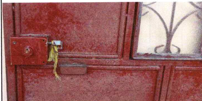
Foto2: Sustitución de chapas: 5 aulas, 1 cocina y 2 para comedor, en mal estado
