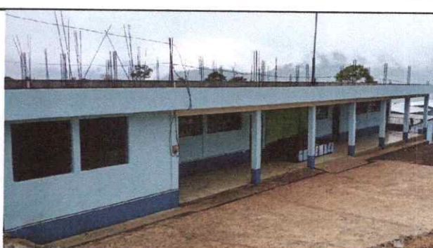
Foto 6: Pintura en muros exteriores.
