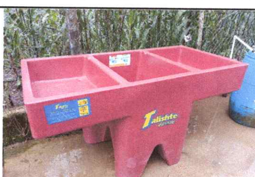
Foto 10: Sustitución de pila de plástico de dos lavaderos.
