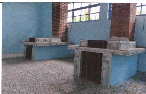
Foto 9: Sustitución de estufa rural (completa) incluye chimenea y plancha de metal.
