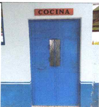
Foto 3: Sustitución de puerta (0.87m*2.00m).
