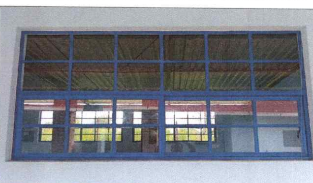
Foto 4: Mejoramiento de ventanas (2.29m de alto *1.25m de ancho).
