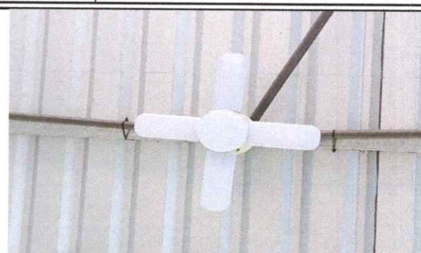
Foto 8: Sustitución de sistema eléctrico.
