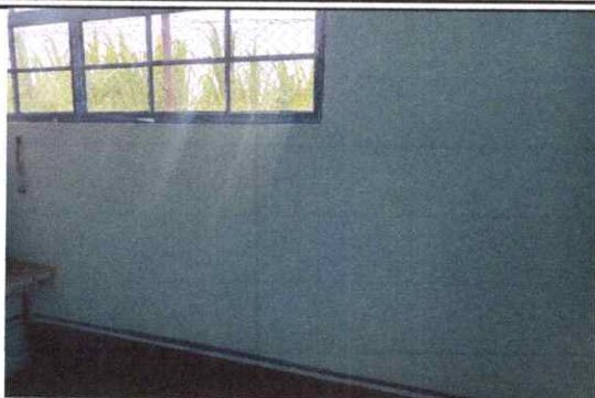
Foto 7: Repello en muro (mono capas).
