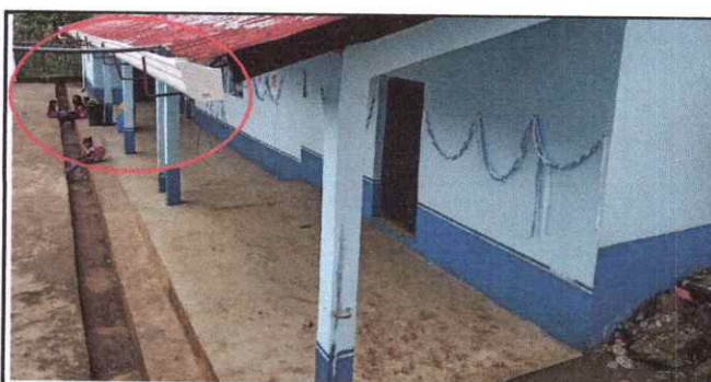
Foto 12: Sustitución de canal de pvc.
