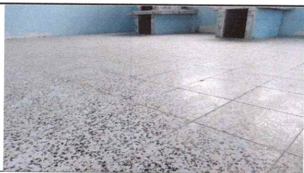
Foto 5: Sustitución de torta de concreto por piso de granito.
