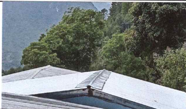
Foto 1: Sustitución de lámina por lámina troquelada aluzinc calibre 26 de 12 pies para tres aulas y cocina.
