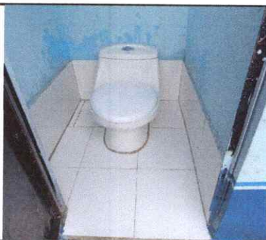
Foto 11: Sustitución de inodoro.
