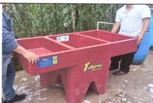
Foto 10: Sustitución de pila de plástico de dos lavaderos.
