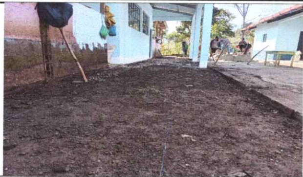
Foto 13: Reparación de planchas de concreto de patio.
