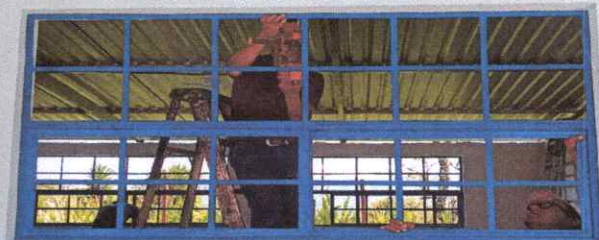
Foto 4: Mejoramiento de ventanas (2.29m de alto *1.25m de ancho).
