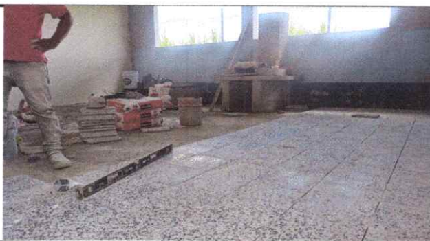
Foto 5: Sustitución de torta de concreto por piso de granito.
