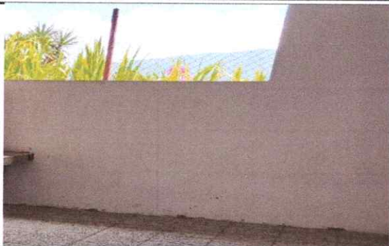
Foto 7: Repello en muro (mono capas).
