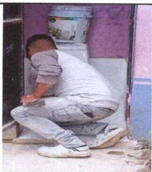
Foto 11: Sustitución de inodoro.
