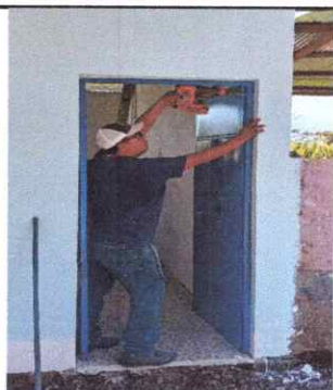
Foto 3: Sustitución de puerta (0.87m*2.00m).
