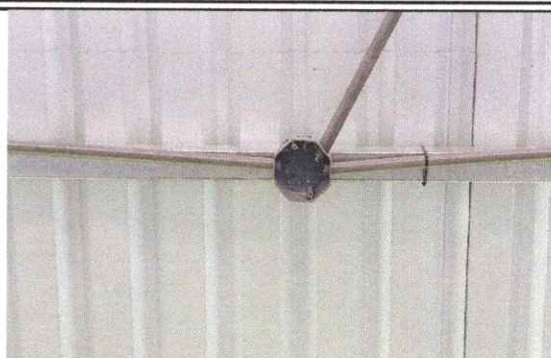
Foto 8: Sustitución de sistema eléctrico.
