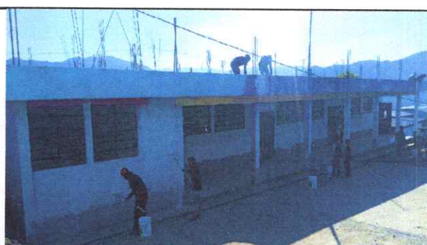
Foto 6: Pintura en muros exteriores.
