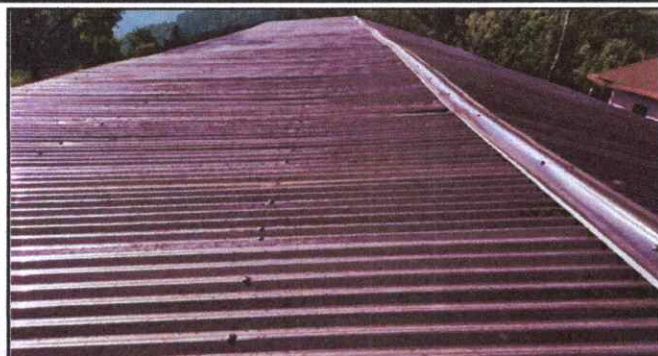
Foto 1: Sustrucción de lámina por lámina troquelada aluzinc calibre 26 de 12 pies para tres aulas y cocina.
