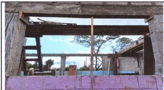
Foto 4: Mejoramiento de ventanas (2.29m de alto *1.25m de ancho).
