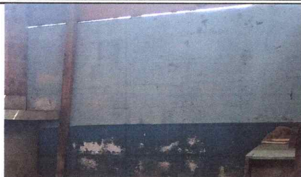
Foto 7: Repello en muro (mono capas).
