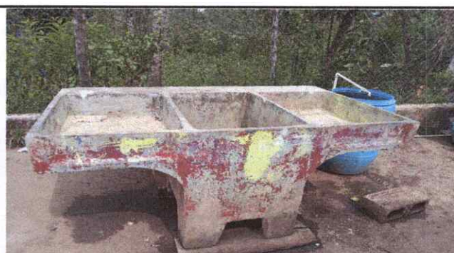
Foto 10: Sustitución de pila de plástico de dos lavaderos.
