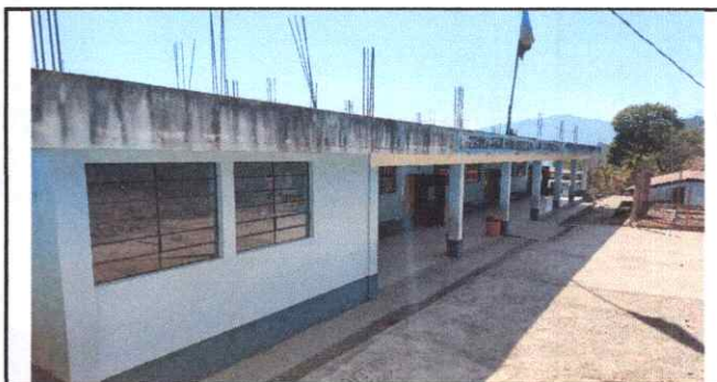
Foto 6: Pintura en muros exteriores.
