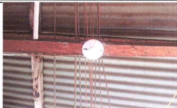
Foto 8: Sustitución de sistema eléctrico.
