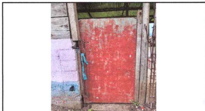
Foto 3: Sustrucción de puerta (0.87m*2.00m).
