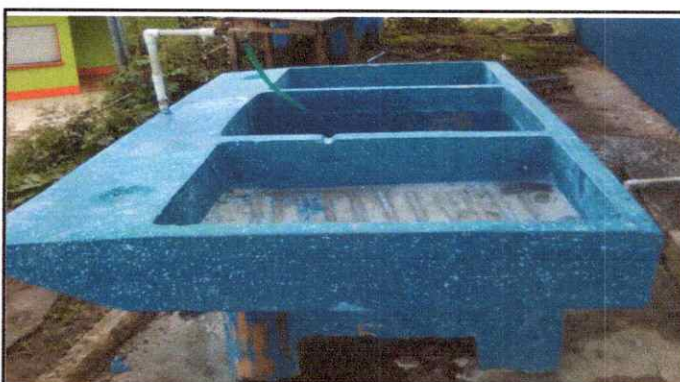
Foto 22: Sustrucción de pila de cemento de dos lavadero
