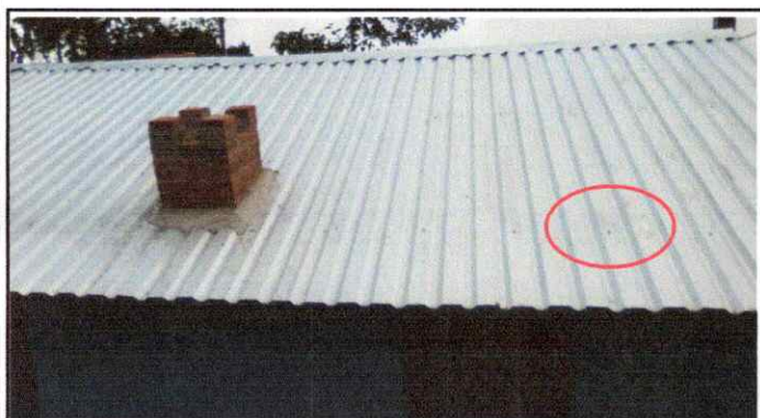
Foto 3: Sustitución de elementos de fijacion
