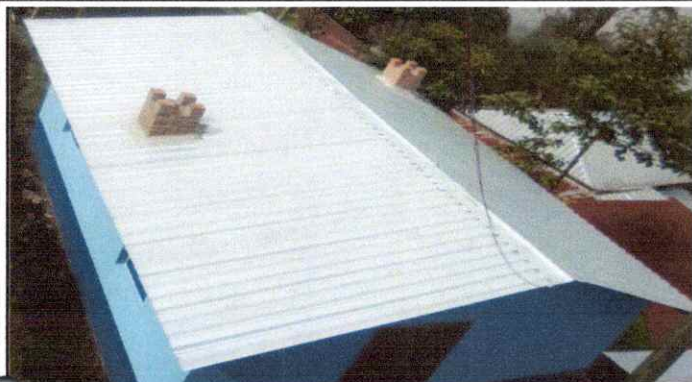
Foto 1: sustitucion de lamina por lamina troquelada
