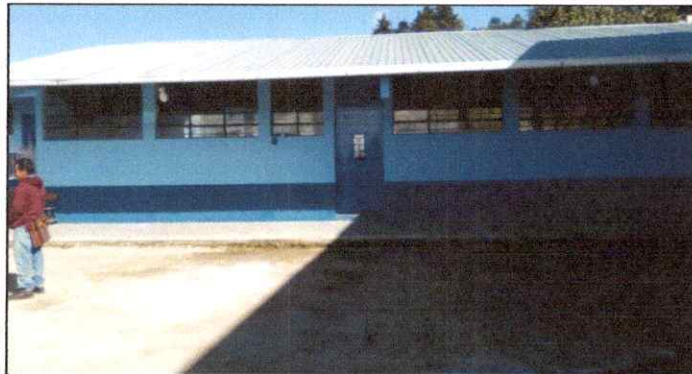
Foto 25: Pintura en muros exteriores e interiores
