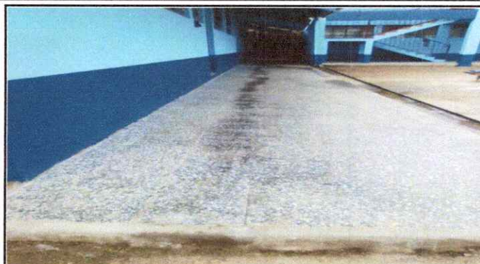
Foto 8: Sustrucción de piso de granito
