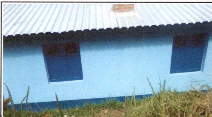
Foto 7: Sustrucción de estructura de metal de ventana
