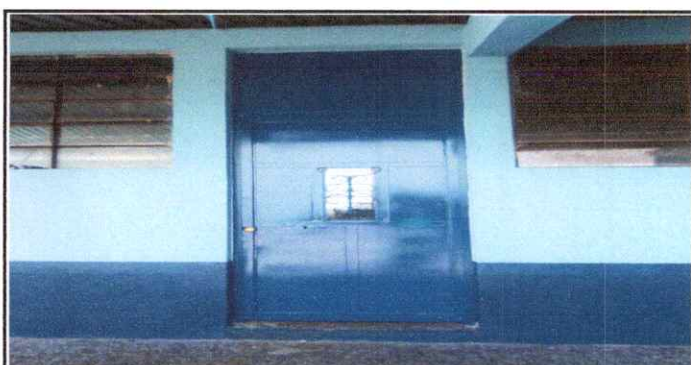
Foto 6: Sustitución de puerta (2.90m de alto * 1.00m de ancho)
