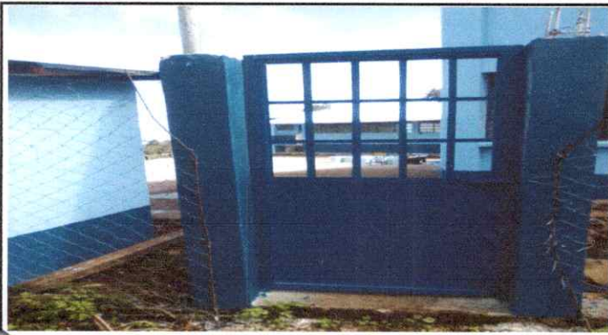
Foto 13: Sustitución de porton de madera por porton de metal *(1.80m de alto x 86cm de ancho)
