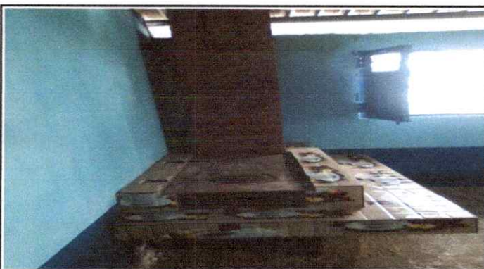
Foto 21: Instalación de azulejo en estufa rural
