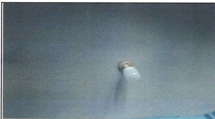
Foto 15: Sustitución de focos ahorradores
