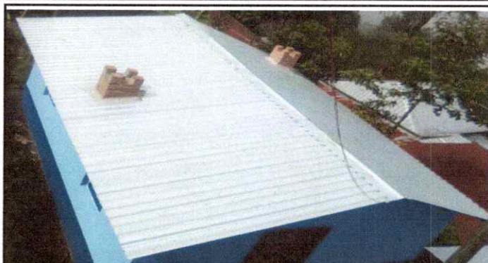
Foto 26: Instalación de estructura portante de metal
