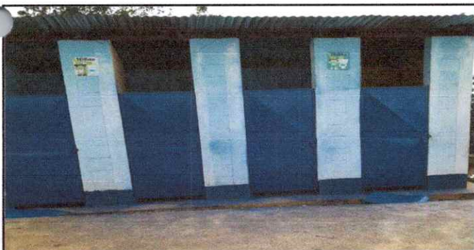
Foto 23: Mantenimiento a estructura (lijado, aplicación de pintura) a puertas servicios sanitarios
