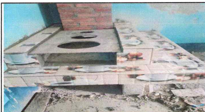
Foto 21: Instalación de azulejo en estufa rural
