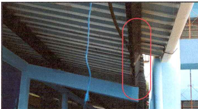
Foto 10: Sustrucción de soporte o pescante de metal para canal
