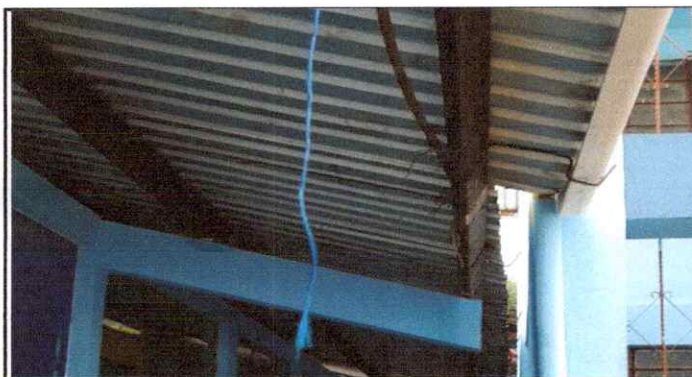
Foto 9: Sustrucción de canal de pvc
