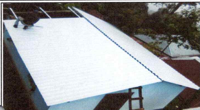
Foto1: sustitucion de lamina por lamina troquelada
