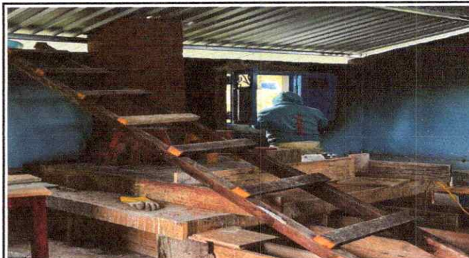
Foto 20: Sustrucción de estufa rural (completa) incluye chimenea de ladrillo, plancha de tres ornillas de metal
