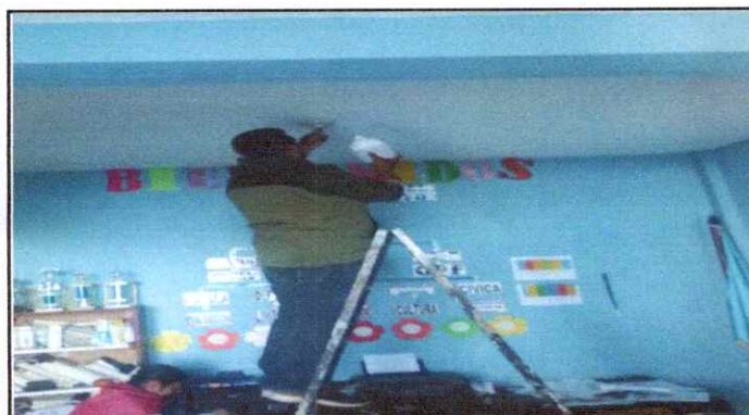
Foto 15: Sustitución de focos ahorradores
