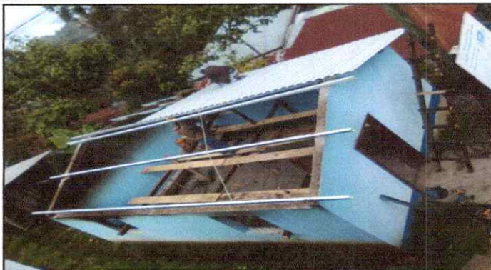
Foto 26: Instalación de estructura portante de metal
