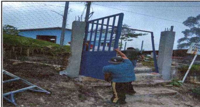
Foto 12: Sustrucción de porton de madera por porton de metal *(2.40m de alto x 2.11m de ancho)
