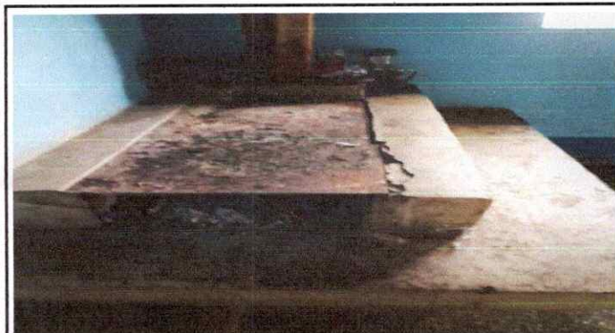
Foto 21: Instalación de azulejo en estufa rural
