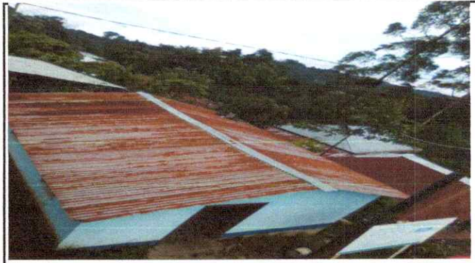
Foto 26: Instalación de estructura portante de metal
