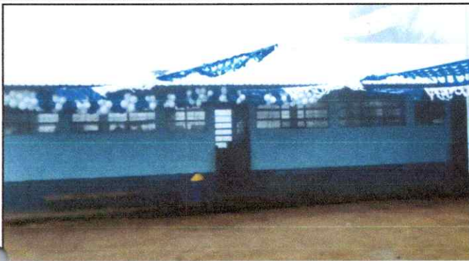
Foto 25: Pintura en muros exteriores e interiores
