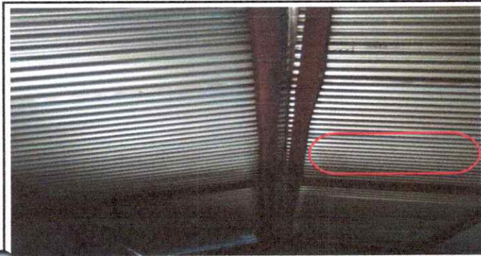
Foto 19: Sustrucción de ducto eléctrico + accesorios
