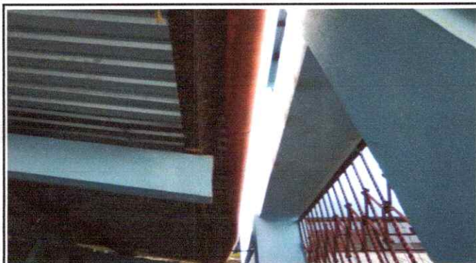
Foto : Sustrucción de canal de pvc
