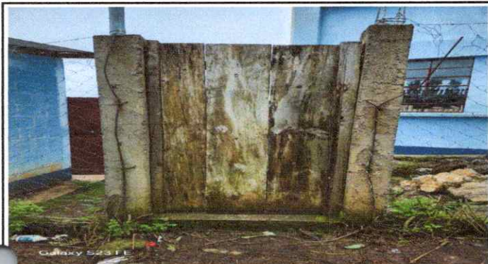
Foto 13: Sustitución de portón de madera por portón de metal *(1.80m de alto x 86cm de ancho)
