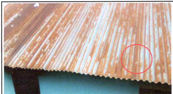
Foto 3: Sustitución de elementos de fijacion
