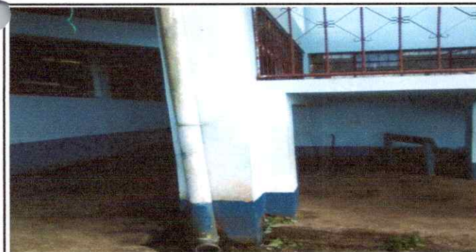
Foto 11: Sustrucción de bajada de agua pluvial de metal por tubo PVC 3"
