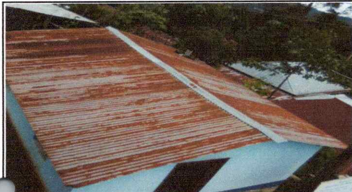
Foto 1: sustitucion de lamina por lamina troquelada
