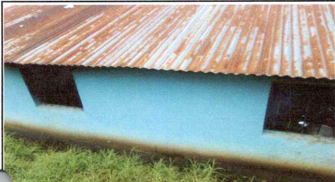
Foto 7: Sustrucción de estructura de metal de ventana
