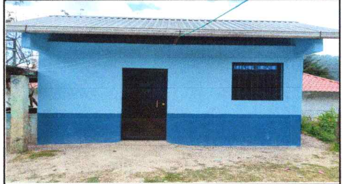
Foto 8: Pintura en muros exteriores e interiores
