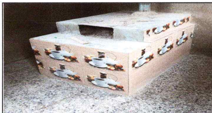
Foto 11: Instalación de azulejo en estufa rural
