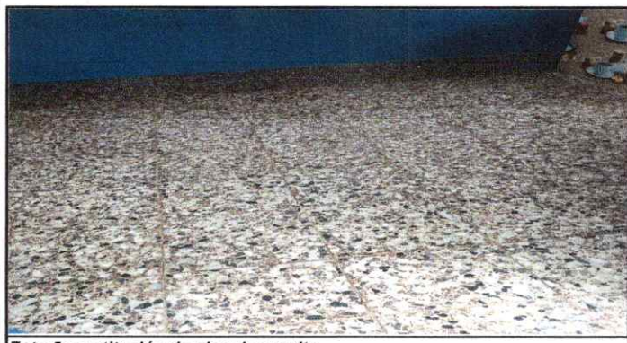
Foto 5: sustitución de piso de granito
