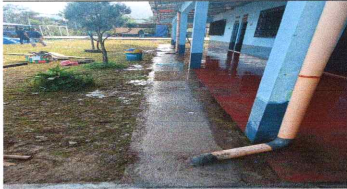
Foto 7: Reparación de cuneta de concreto
