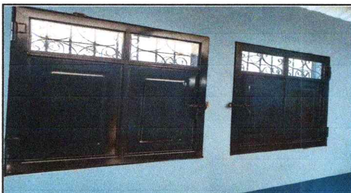
Foto 4: Sustitución de estructura de metal de ventana
