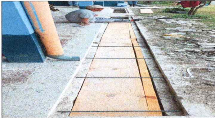
Foto 7: Reparación de cuneta de concreto
