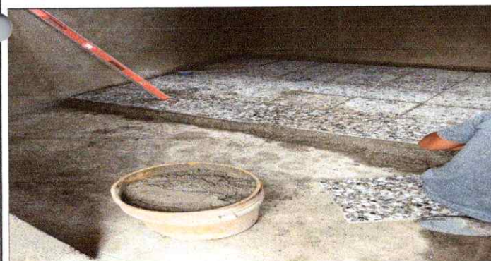
Foto 5: sustitución de piso de granito
