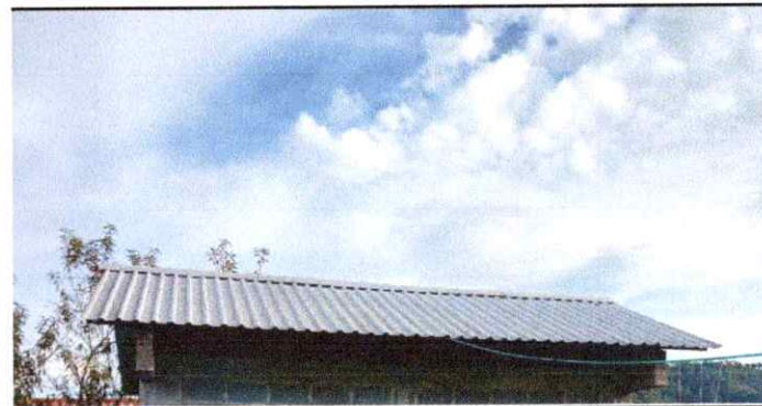
Foto 6: sustitución de canal de metal
