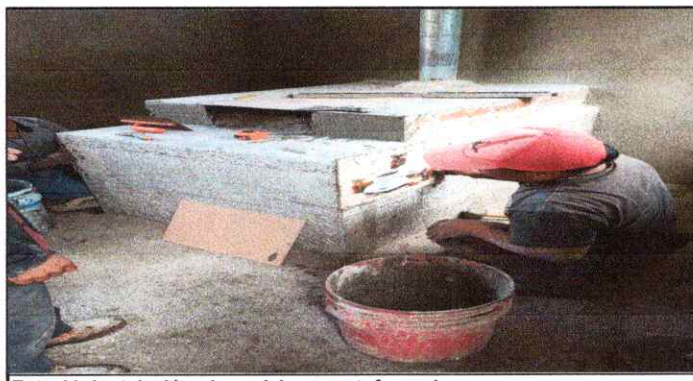
Foto 11: Instalación de azulejo en estufa rural
