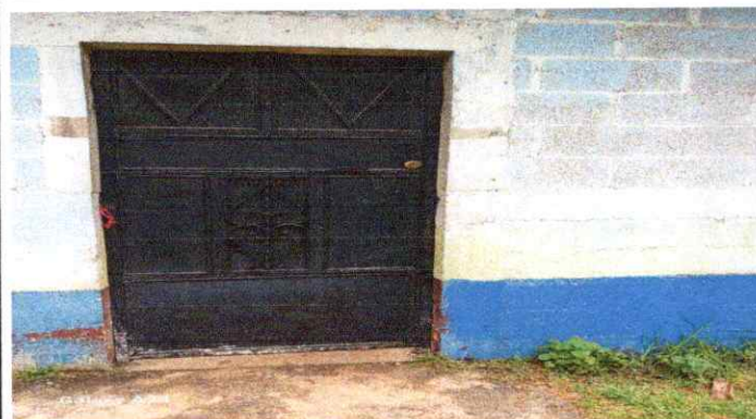
Foto 3: Sustitución de puerta
