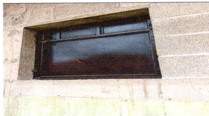
Foto 4: Sustitución de estructura de metal de ventana
