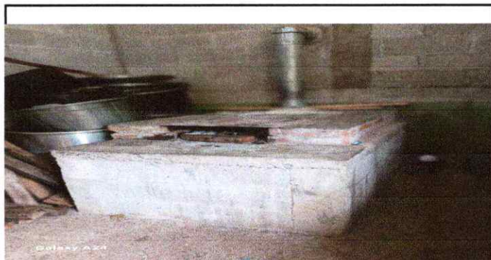
Foto 11: Instalación de azulejo en estufa rural
