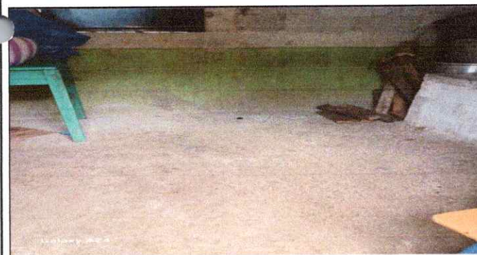
Foto 5: sustitución de piso de granito
