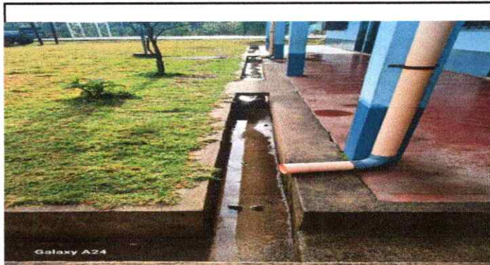
Foto 7: Reparación de cuneta de concreto
