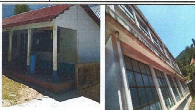
Foto 2: Pintura de muros exteriores e interiores
