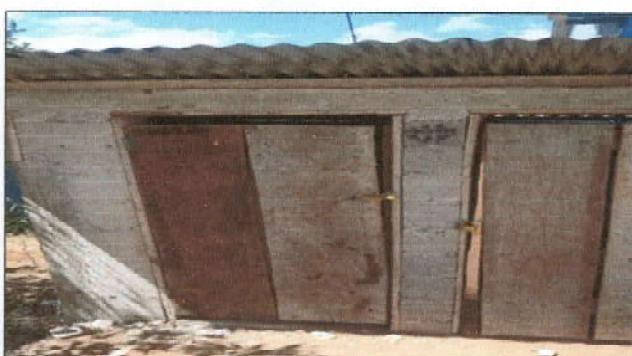
Foto 4: Sustitución de puertas de sanitarios
