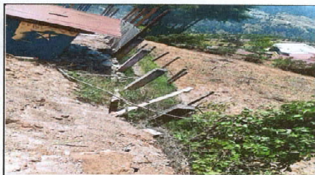
Foto 3: Mejoramiento de muros y maya
