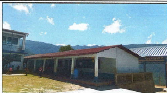
Foto1: Sustitución de bajada de agua
