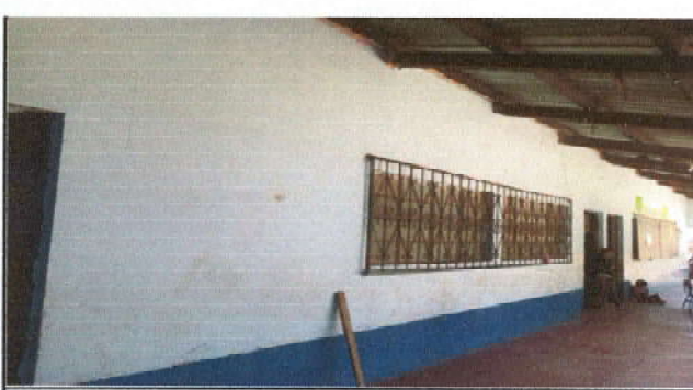
Foto 6: Sustitución de techo
