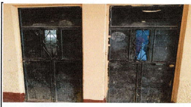
Foto 4: Sustitución de Puerta
