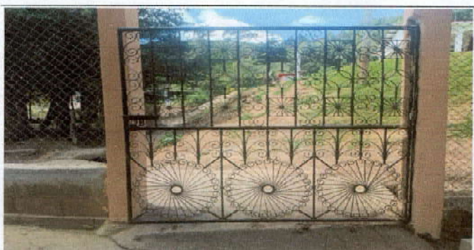
Foto 11: Mantenimiento a portones de metal
