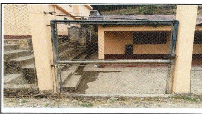
Foto 6: Sustitución del portón de malla a portón de metal
