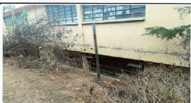
Foto 12: Reparación de tubo hg y malla galvanizada (9 tubos y 4 mallas)
