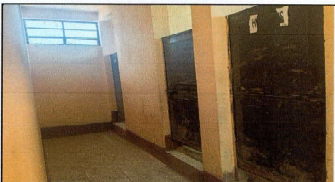
Foto 9: Mantenimiento a estructura ( fijado, cepillado y aplicación de pintura de aceite) a puertas servicios sanitarios
