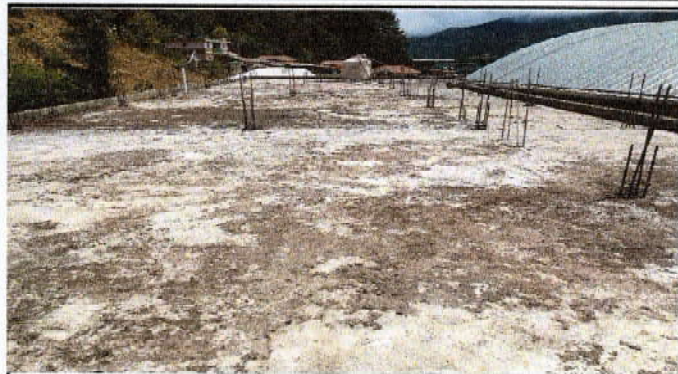
Foto 1: Impermeabilización de loza
