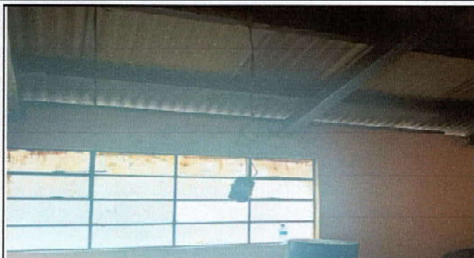
Foto 7: Sustitución de Vidrios figurados a vidrios transparentes de 49*24 cm
