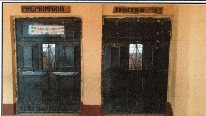
Foto 2: Mantenimiento a estructura (lijado, cepillado y aplicación de pintura de aceite)
