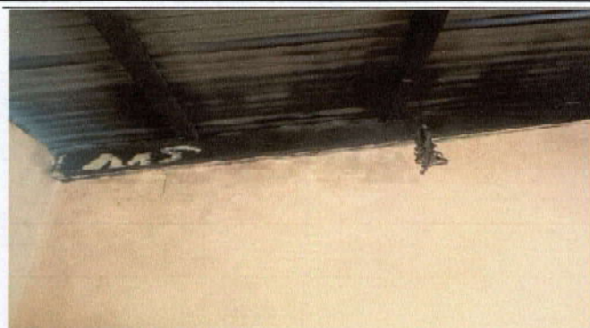
Foto 8: Pintura en muros exteriores e interiores Pintura en muros exteriores e interiores
