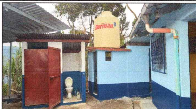
foto 8: Sustrucción de deposito de agua de 2500 litros
