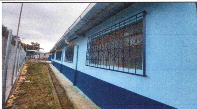
Foto 2: Mantenimiento a balcones de metal
