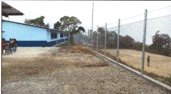
Foto 7: Sustrucción de tubo hg y malla galvanizada
