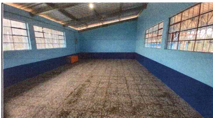
Foto 3: Sustitución de piso de torta de concreto
