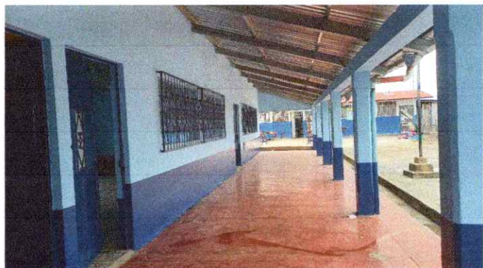
Foto 4: Pintura en muros exteriores e interiores
