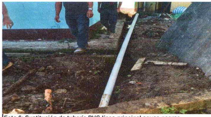
Foto 6: Sustitución de tubería PVC línea principal aguas negras
