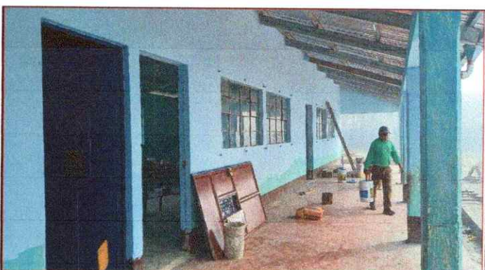
Foto 4: Pintura en muros exteriores e interiores
