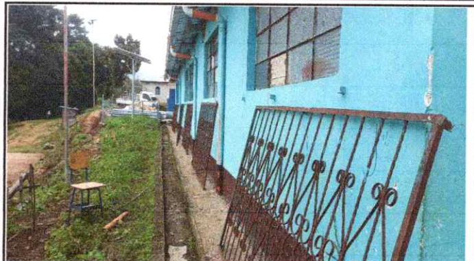
Foto 2: Mantenimiento a balcones de metal
