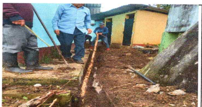
Foto 6: Sustitución de tubería PVC línea principal aguas negras
