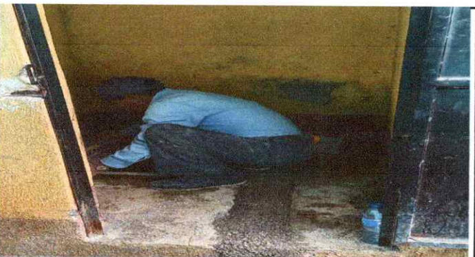
Foto 5: Sustitución de Inodoros.
