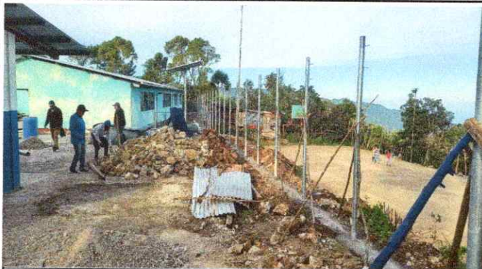
Foto 7: Sustitución de tubo hg y malla galvanizada
