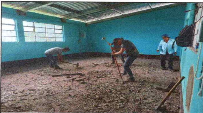
Foto 3: Sustitución de piso de torta de concreto
