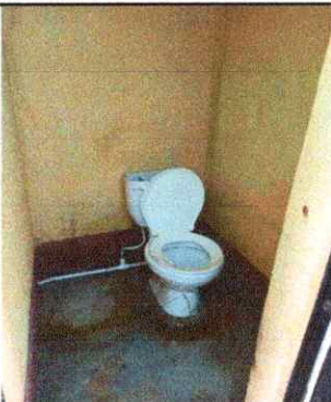
Foto 5: Sustitución de Inodoros.
