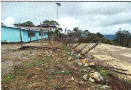
Foto 7: Sustrución de tubo hg y malla galvanizada
