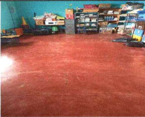
Foto 3: Sustitución de piso de torta de concreto
