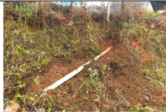
Foto 6: Sustitución de tubería PVC línea principal aguas negras
