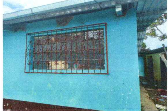
Foto 2: Mantenimiento a balcones de metal
