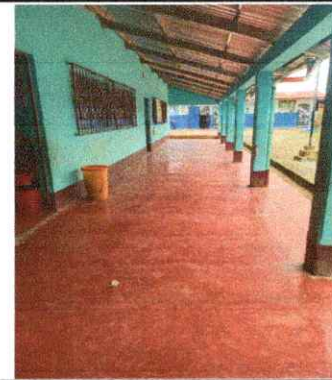
Foto 4: Pintura en muros exteriores e interiores
