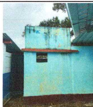
foto 8: Sustrución de deposito de agua de 2500 litros
