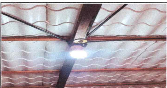
17: Reparación de cableado eléctrico
