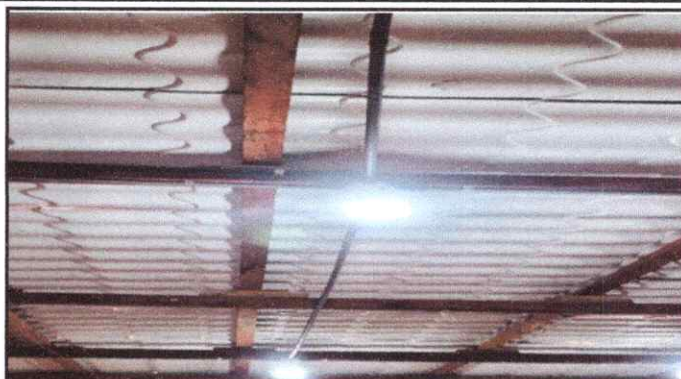
Foto 20: Instalación Unidades Luz (interruptor, ducto y cable eléctrico)
