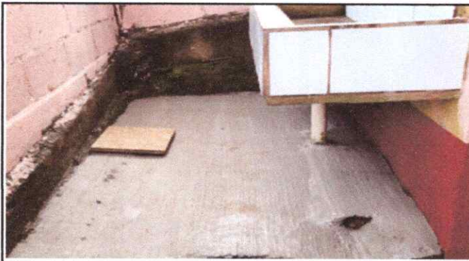
Foto 9: Sustitución de tubería línea principal
