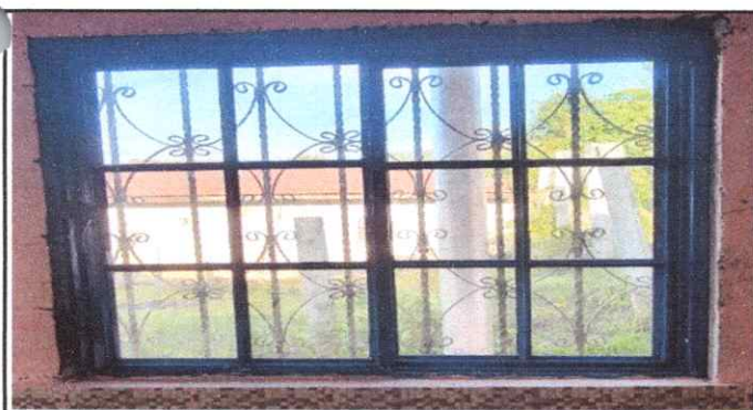
Foto 5: Sustitución de estructura de metal de ventana
