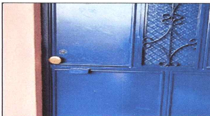
Foto 4: Sustitución de chapa
