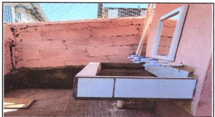
Foto 10: Sustitución de llave de chorro
