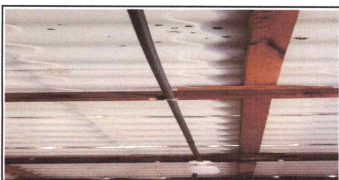
18: Sustrucción de ducto eléctrico y mas accesorios
