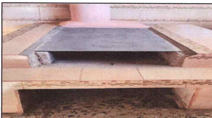
Foto 22: Sustitución de plancha de metal de 3 hornillas
