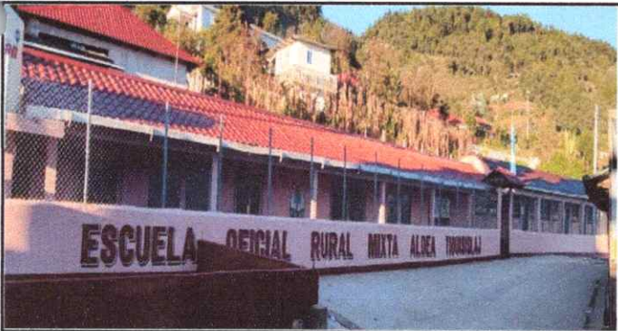
Foto 11: Reparación de tubo hg y malla galvanizada
