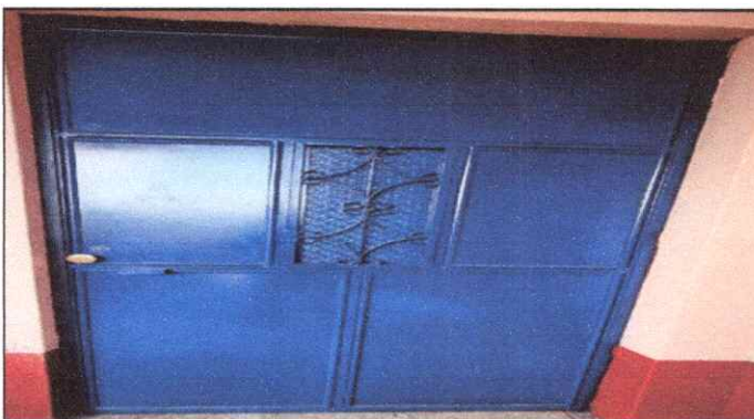
Foto 3: Mantenimiento a estructura: Lijado, cepillado y aplicado de pintura
