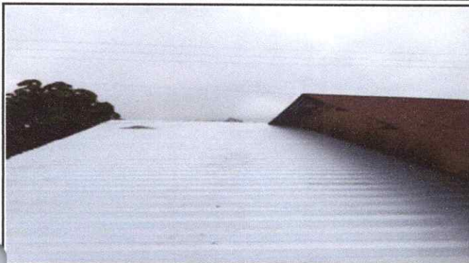
Foto 1: Sustitución de lámina por lamina troquelada calibre 26
