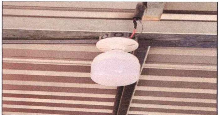
Foto 12: Sustitución de lamparas tipo LED
