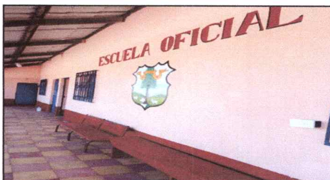
Foto 6: Pintura en muros exteriores e interiores
