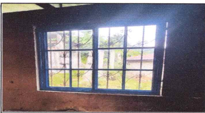
Foto 5: Sustitución de estructura de metal de ventana
