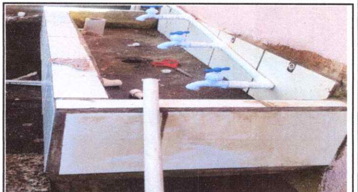
Foto 10: Sustitución llaves de chorros
