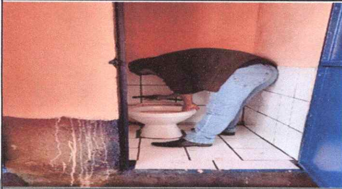
Foto 7: Sustitución de inodoro
