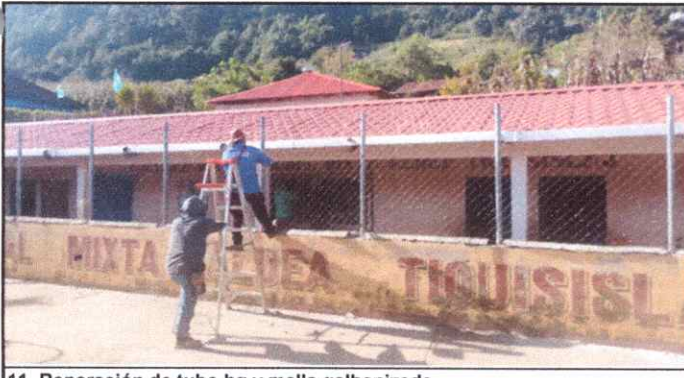
11. Reparación de tubo hg y malla galvanizada
