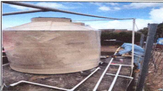
Foto 19: Sustitución de depósito de agua de 1,700 litros
