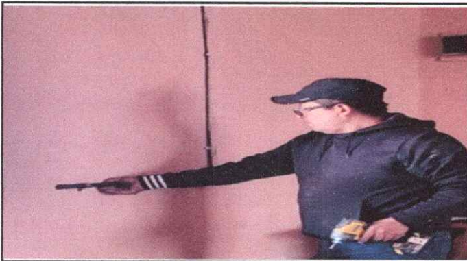
Foto 15: Sustitución de tomacorrientes dobles
