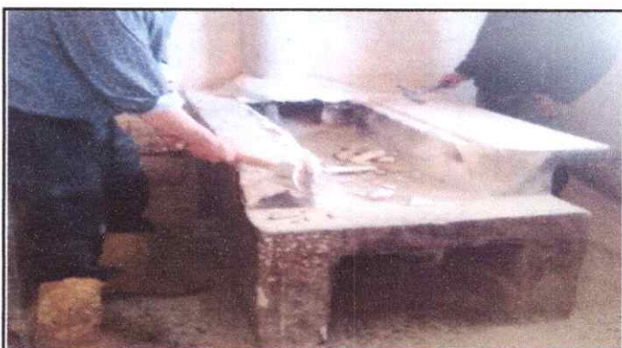
Foto 22: Sustitución de plancha de metal de 3 hornillas
