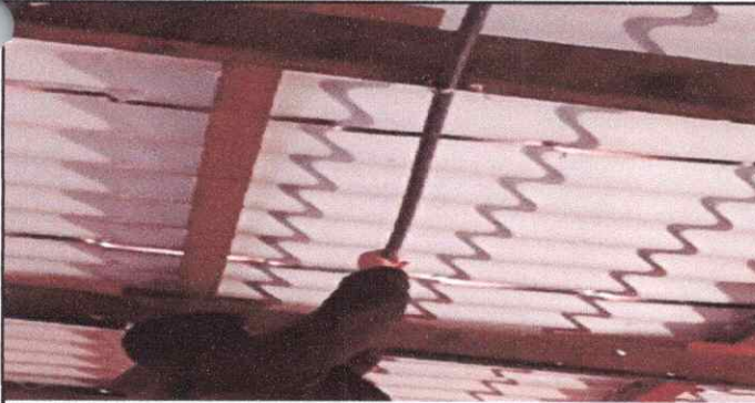
Foto 17: Reparación de cableado eléctrico
