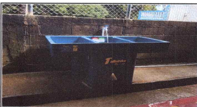
Foto 24: Sustitución de pila de cemento de dos lavaderos por una de plástico
