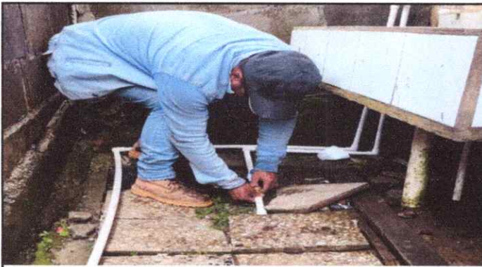
Foto 9: Sustitución de tubería línea principal
