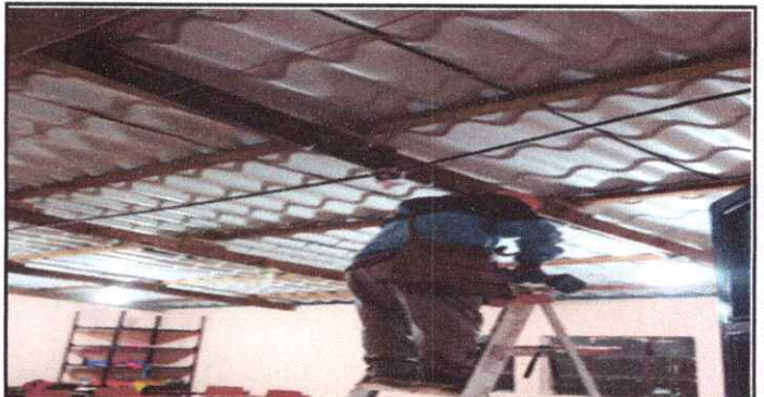
Foto 18: Sustitución de ducto eléctrico y mas accesorios
