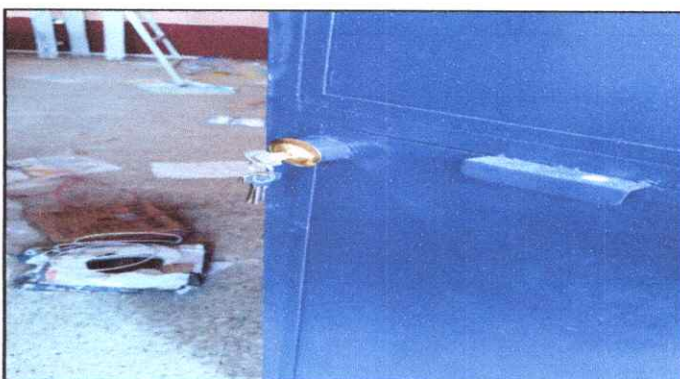
Foto 4: Sustitución de chapas
