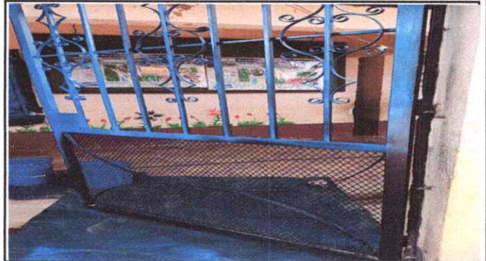
Foto 8: Mantenimiento a portones de metal
