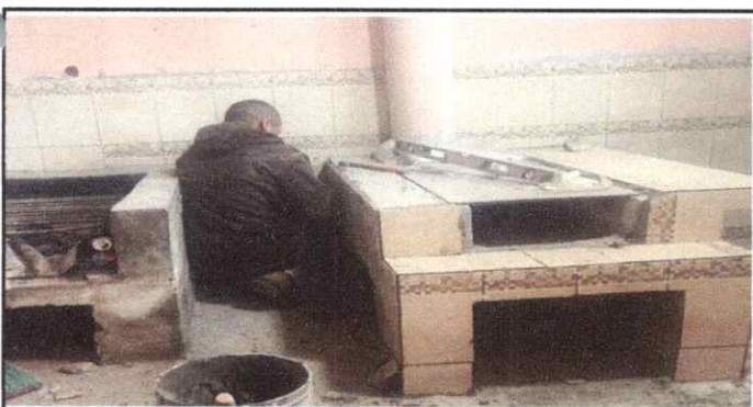
Foto 23: Instalación de azulejo en estufa rural
