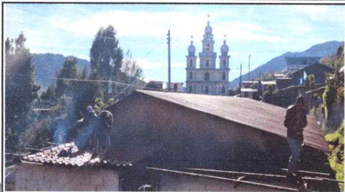
Foto 1: Sustitución de lámina por lamina troquelada calibre 26
