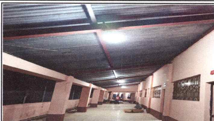
Foto 20: Instalaciones de unidades luz (interruptor, ducto y cable eléctrico)
