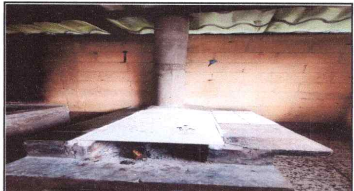
Foto 22: Sustitución de plancha de metal de 3 hornillas
