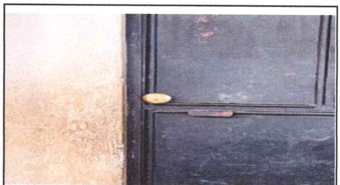
Foto 4: Sustitución de chapas
