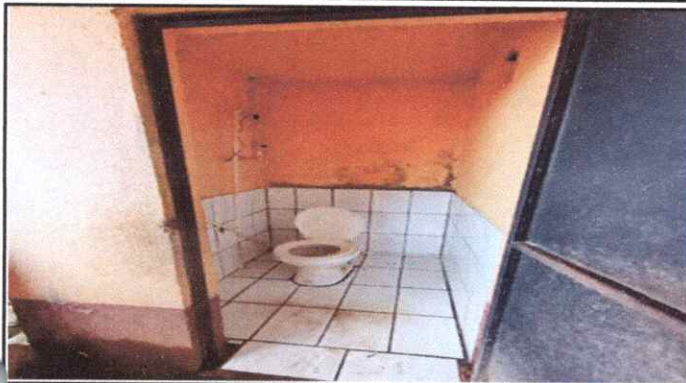
Foto 7: Sustrucción de inodoro
