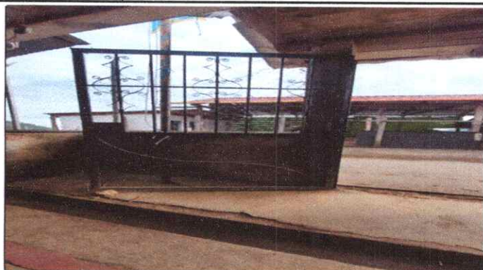
Foto 8: Mantenimiento a portones
