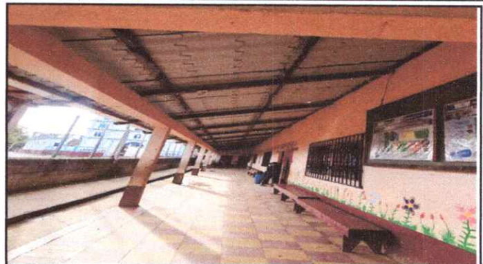
Foto 20: Instalación de unidades luz (interruptor, ducto y cable eléctrico)
