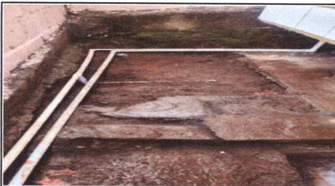
Foto 9: Sustrucción de tubería línea principal
