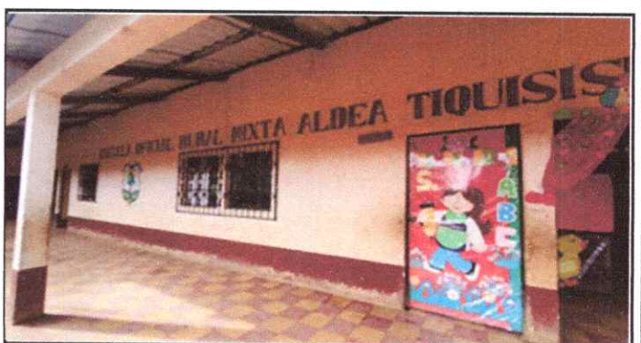
Foto 6: Pintura en muros exteriores e interiores
