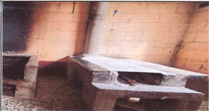
Foto 23: Instalación de azulejo en estufa rural
