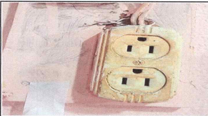
Foto 15: Sustrucción de tomacorrientes dobles
