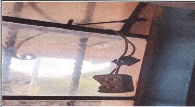
Foto 21: Instalación unidad fuerza (tomacorriente, flípones y tablero)
