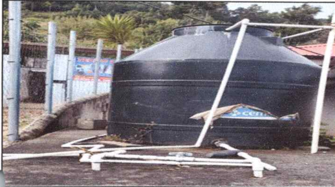
Foto 19: Sustitución de deposito de agua de 1,700 litros
