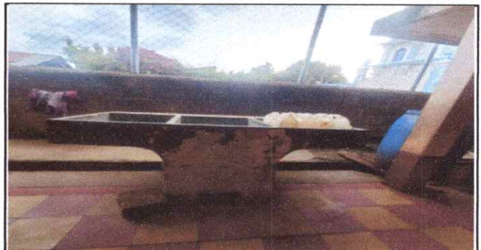
Foto 24: Sustitución de pila de cemento de dos lavaderos por una de plástico
