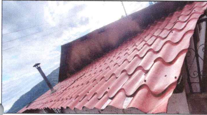
Foto 1: Sustitución de lámina por lamina troquelada para cocina
