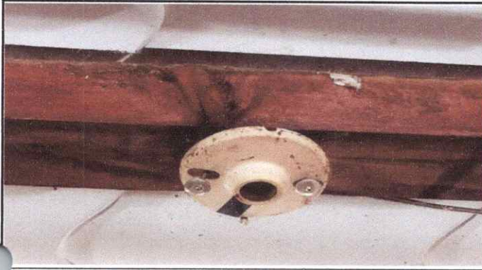
Foto 13: Sustrucción de plafoneras
