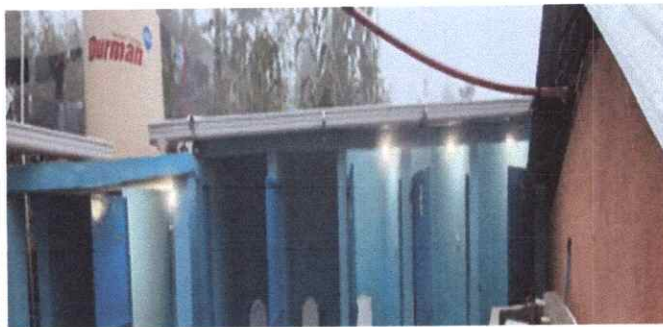
Foto 2: 10.1, 10.2, 10.3, 10.4 Sustitución de: cableado eléctrico, plafoneras, interruptores y focos ahorradores
