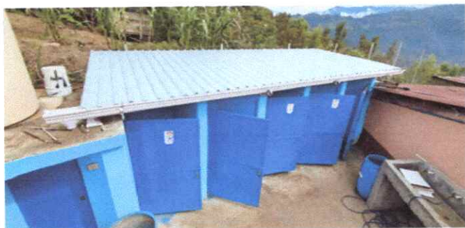
Foto 1: 7.1, 7.2 y 8.1 Sustitución de: lámina, elementos de fijación y estructura de soporte de madera por metal
