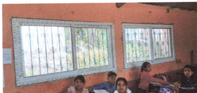
Foto 1: 1.1 y 1.2 Sustitución de ventanas de metal por pvc
