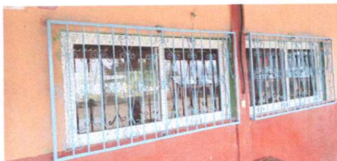
Foto 2: 1.3 Mantenimiento a balcones
