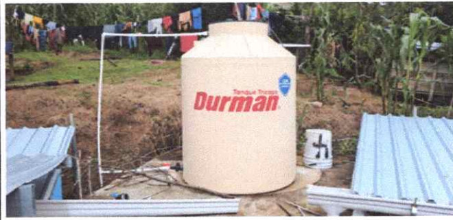
Foto 6: 6.1 Sustitución de depósito de agua
