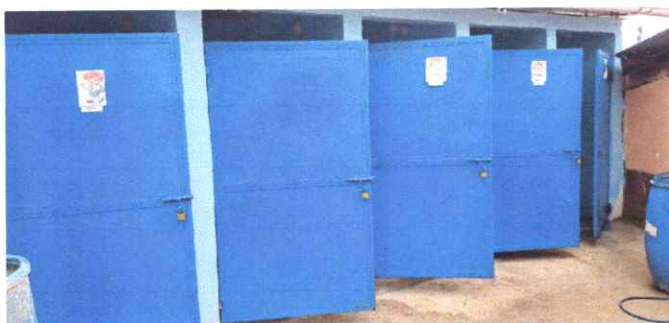
Foto 3: 2.1 Sustitución de puertas de metal
