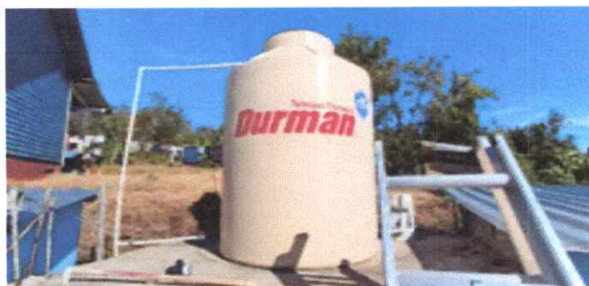
Foto 6: 6.1 Sustitución de depósito de agua
