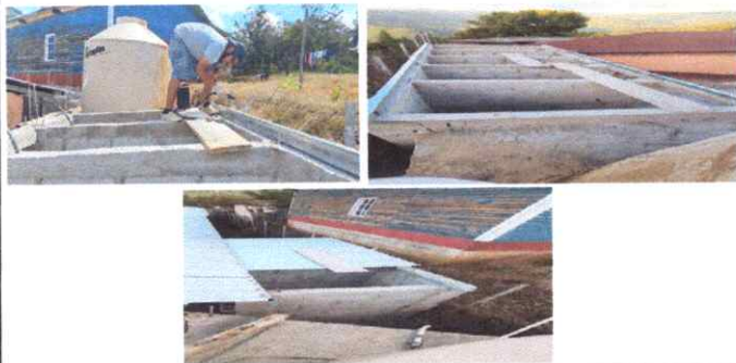
Foto 1: 7.1, 7.2 y 8.1 Sustituciones de: lámina, elementos de fijación y estructura de soporte de madera por metal
