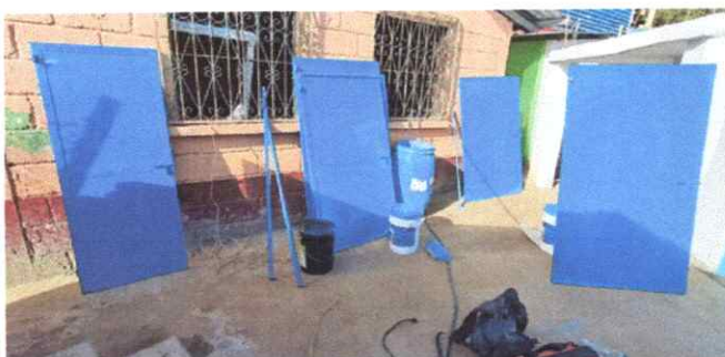
Foto 3: 2.1 Sustitución de puertas de metal
