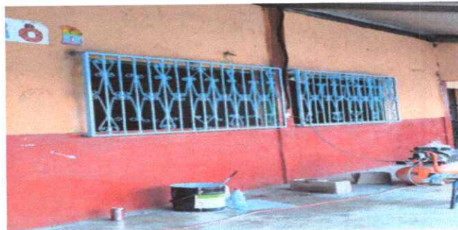
Foto 2: 1.3 Mantenimiento a balcones
