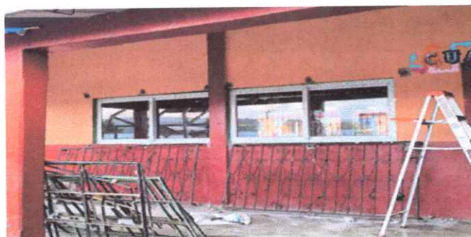
Foto 1: 1.1 y 1.2 Sustitución de ventanas de metal por pvc
