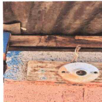
Foto 2: 10.1, 10.2, 10.3, 10.4 Sustituciones de: cableado eléctrico, plafoneras, interruptores y focos ahorradores
