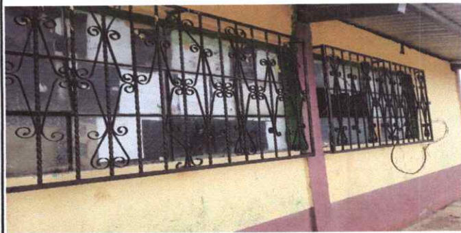
Foto 2: 1.3 Mantenimiento a balcones
