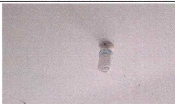
Foto 12: Sustitución de plafoneras
