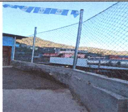
Foto 10: Sustitución de tubo hg y malla galvanizada
