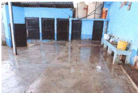
Foto 7: Sustitución de plancha de concreto de patio
