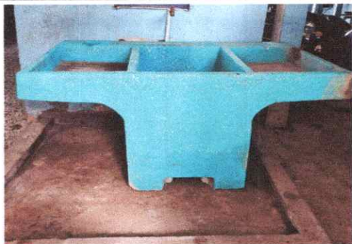
Foto 9: Sustitución de pila de cemento por pila de cemento de dos lavaderos
