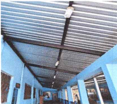
Foto 2: Sustitución de soporte de metal por metal.
