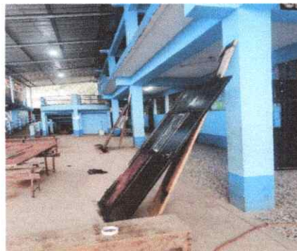
Foto 3: Mantenimiento a estructura (lijado, cambio de tubo, cepillado, sujeciones, aplicación de pintura)
