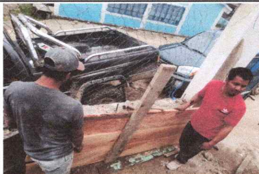
Foto 10: Sustrución de tubo hg y malla galvanizada
