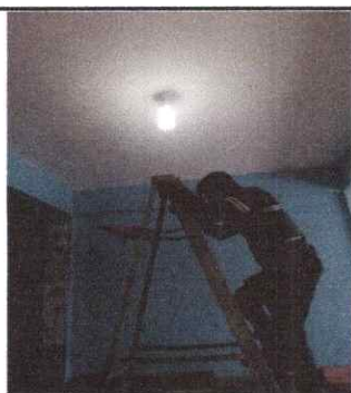
Foto 11: Sustrución de focos ahorradores.
