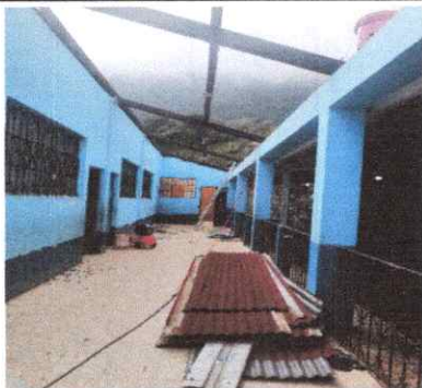
Foto 2: Sustitución de soporte de metal por metal.
