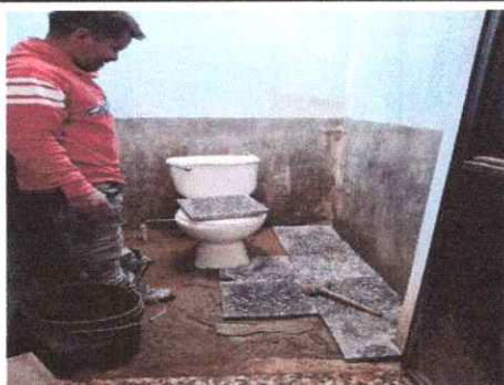
Foto 5: Sustitución de piso de torta de concreto por piso de granito.
