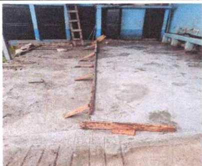
Foto 7: Sustrución de plancha de concreto de patio
