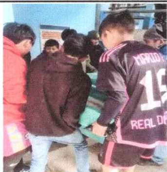
Foto 9: Sustrución de pila de cemento por pila de cemento de dos lavaderos
