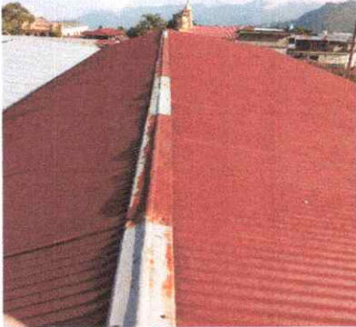
Foto 1: Sustrucción de lámina por lámina troquelada Aluzinc calibre 26.
