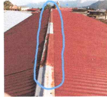
Foto 2: Sustrucción de capote de lámina por lámina troquelada
