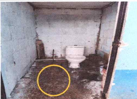
Foto 5: Sustrucción de piso de torta de concreto por piso de granito.
