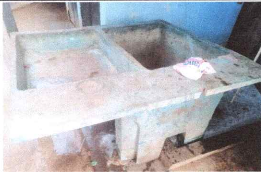
Foto 9: Sustitución de pila de cemento por pila de cemento de dos lavaderos
