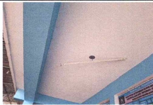
Foto 12: Sustitución de plafoneras
