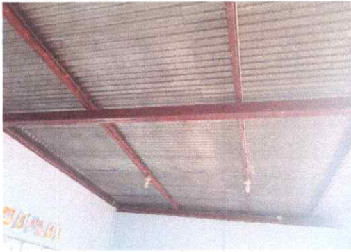
Foto 2: Sustrucción de soporte de metal por metal.
