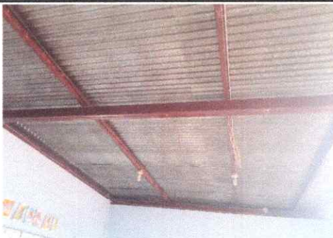
Foto 11: Sustitución de focos ahorradores.
