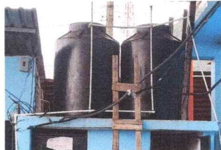
Foto 8: Sustitución de depósito de agua de 1,100 lt
