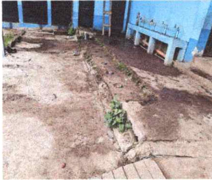
Foto 7: Sustitución de plancha de concreto de patio
