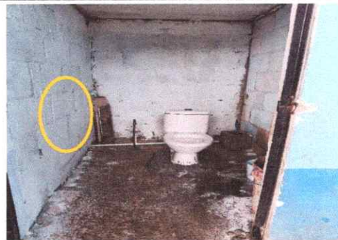
Foto 6: Mejoramiento de azulejo en modulo de baños
