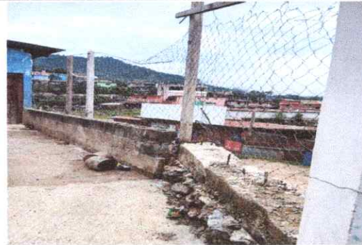
Foto 10: Sustitución de tubo hg y malla galvanizada
