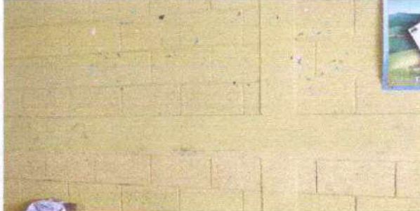
Foto 12: Pintura de muros interno
