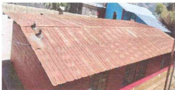
Foto1: Sustrución de lámina por lámina troquelada Aluzin Calibre 26
