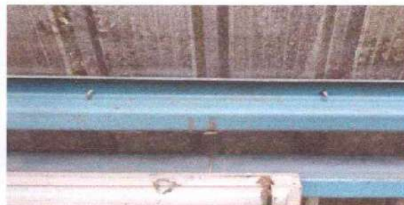
Foto 4: sustrución de elementos de fijación
