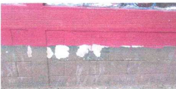
Foto 11: Pintura de muros externo
