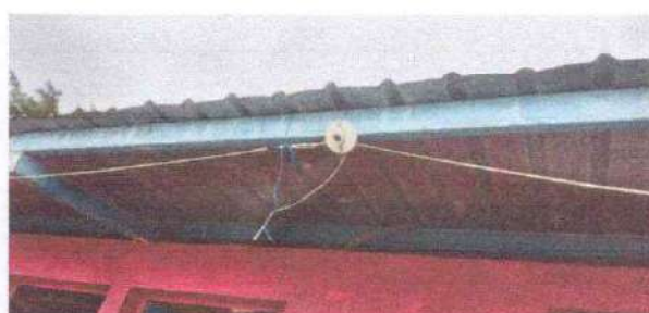
Foto 16: Reparación de sistema eléctrico. Plafoneras
