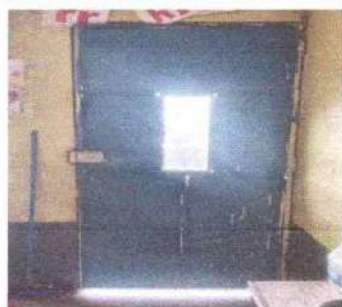
Foto 5: mantenimiento de puertas de metal
