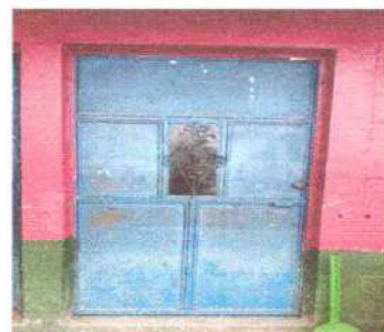
Foto 6: mantenimiento de puertas de metal
