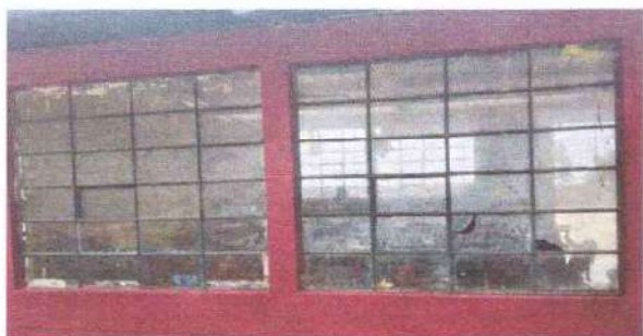
Foto 7: Sustitución de vidrios
