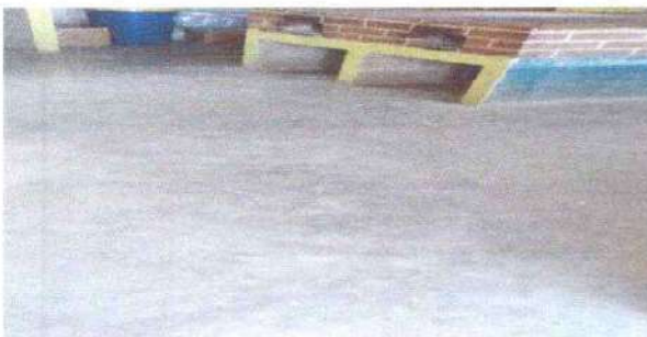
Foto 9: Sustitución de torta de cemento por piso granito de cocina
