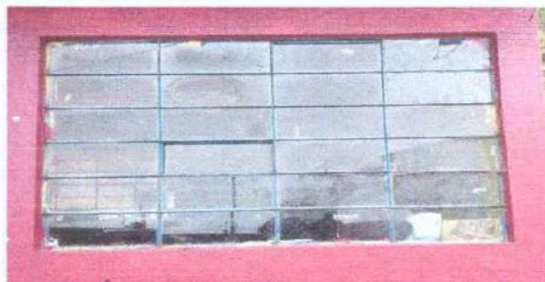
Foto 8: Sustitución de vidrios
