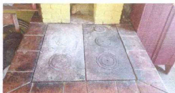
Foto 18: Reparación de planchas de tres hornillas
