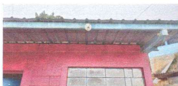
Foto 15: Reparación de sistema eléctrico. Focos ahorradores
