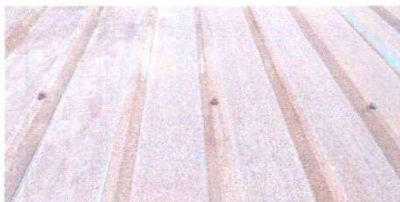
Foto 3: sustrución de elementos de fijación
