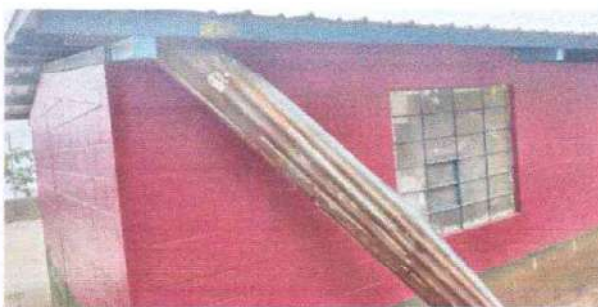
Foto 10: Sustitución de canal de metal
