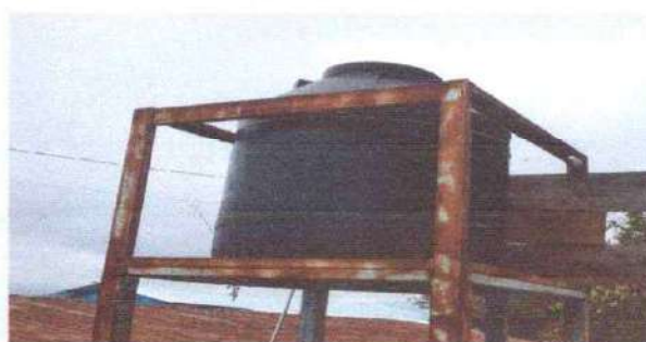
Foto 14: Sustitución de depósito de almacenamiento de agua de 2500 Lt
