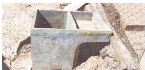
Foto 17: Reparación de pila plástica de dos lavaderos
