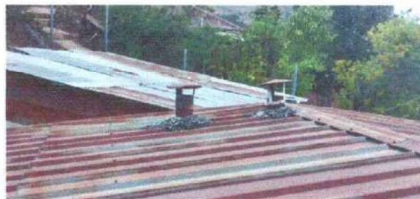
Foto 20: Reparación de chimenea
