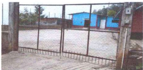
Foto 13: mantenimiento de portón de metal
