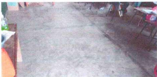
Foto 21: sustitución de torta de cemento por piso en las aulas
