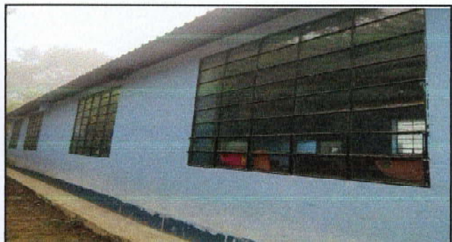
Foto 4: Mejoramiento de balcones
