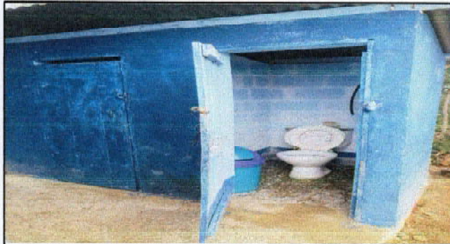
Foto1: Mejoramiento de puertas, tazas de baño, regla de maderas por costaneras piso y láminas
