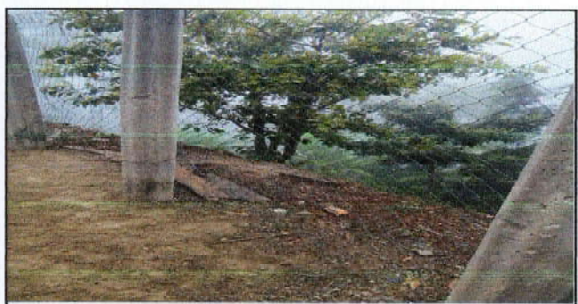
Foto 6: Reparación de muro perimetral.
