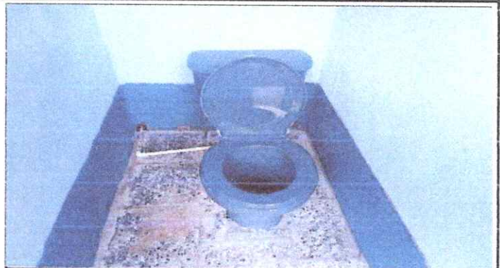
8. Sustitución de inodoro
