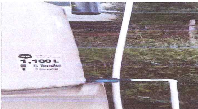
Foto 9: Sustitución de red general de drenaje
