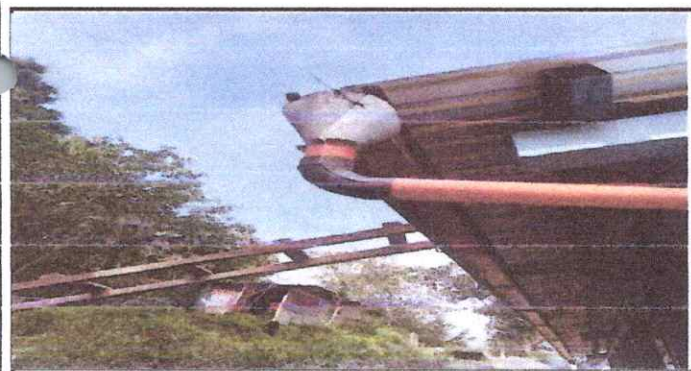
Foto 23. Reparación de bajada de agua pluvial PVC 3"
