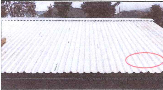
3. Sustitución de elemento de fijación
