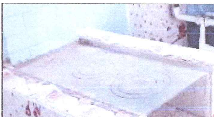
Foto 16: Sustitución de plancha 3 hornillas
