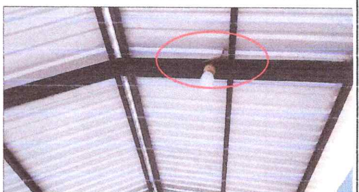
Foto 10: Sustitución de focos ahorradores
