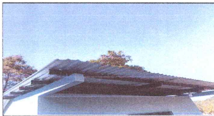
Foto 24: Sustrucción de soporte o pescante de metal para canal.
