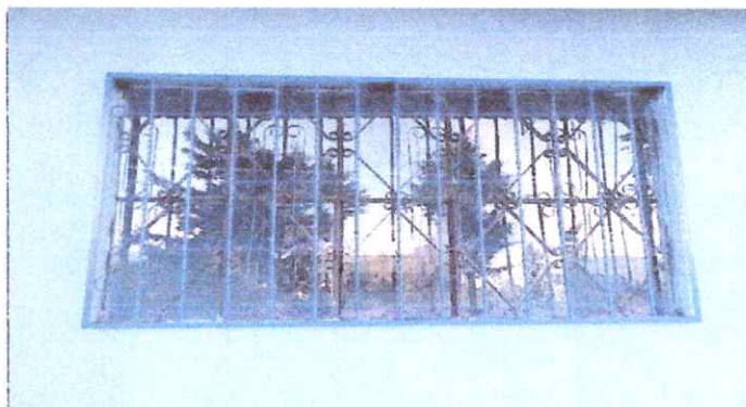
Foto 22: Mejoramiento de balcones de metal
