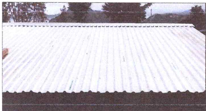
15. Mano de obra por instalación de lámina alucinc
