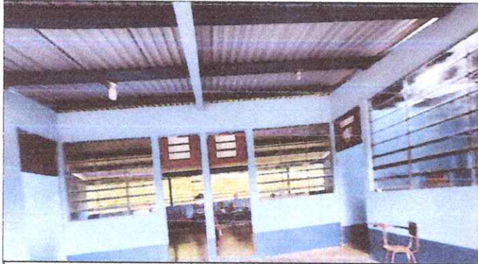
Foto 7: Pintura en muros en exteriores e interiores
