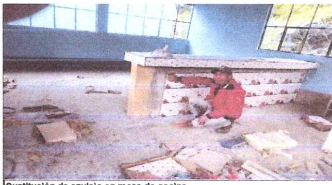
Sustitución de azulejo en mesa de cocina
