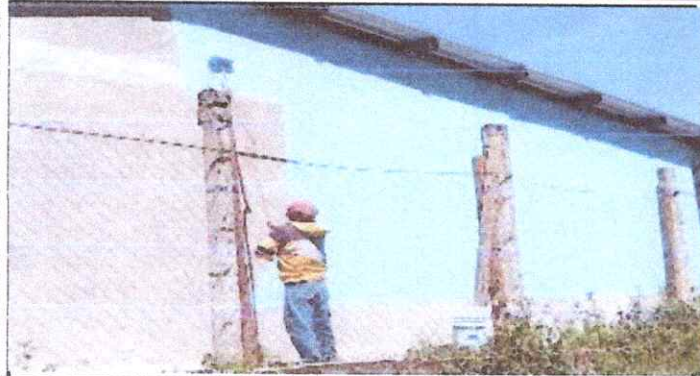
Foto 7: Pintura en muros en exteriores e interiores
