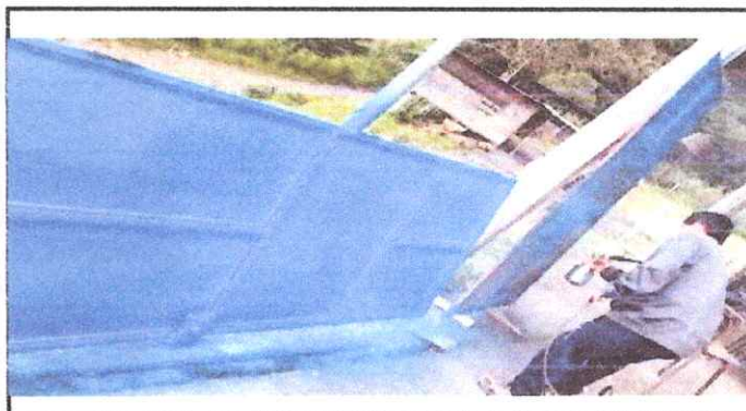
Foto 4: Mantenimiento de estructura de metal de puertas
