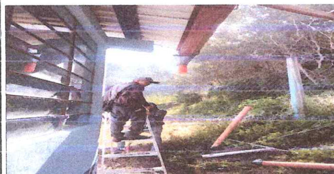
Foto 23. Reparación de bajada de agua pluvial PVC 3"
