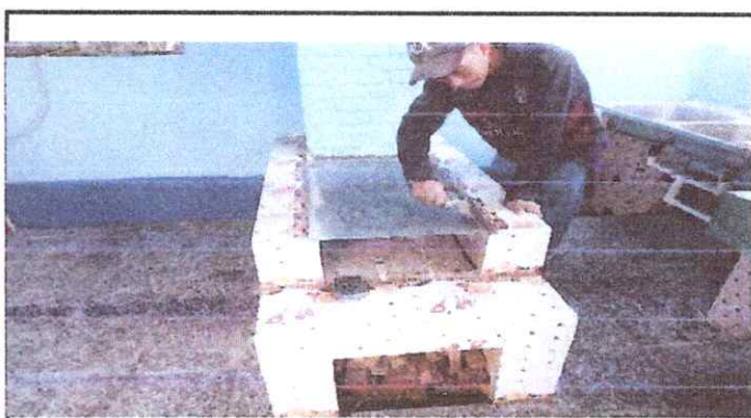
Foto 16: Sustitución de plancha 3 hornillas
