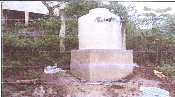
Foto 14: Sustitución de depósitos de agua 1,100 Lt.
