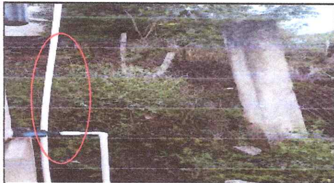
Foto 9: Sustitución de red general de drenaje
