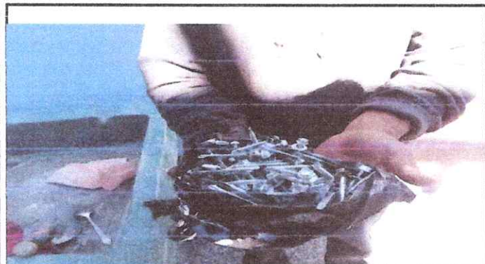
3. Sustitución de elemento de fijación
