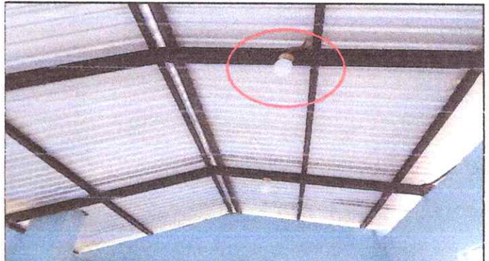
Foto 10: Sustitución de focos ahorradores
