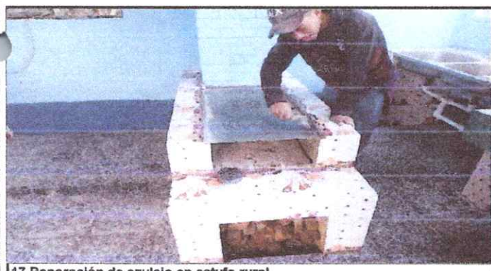
17. Reparación de azulejo en estufa rural
