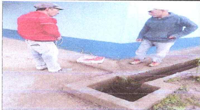
Foto 13: Sustitución de ducto eléctrico
