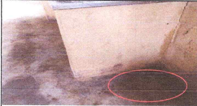
Foto 19: Sustrucción de pila de cemento
