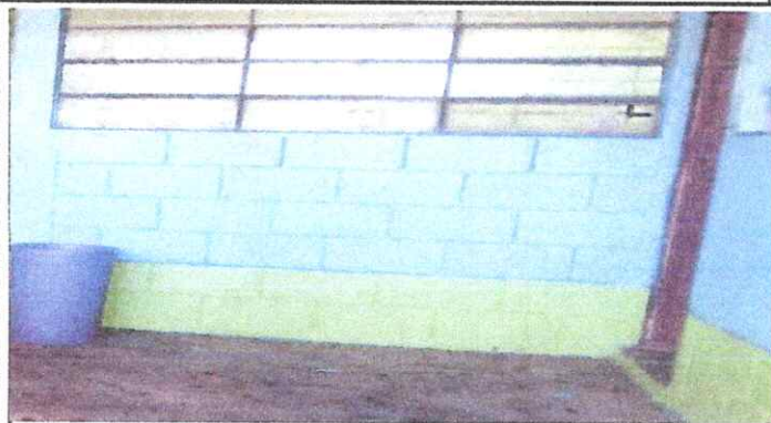
Foto 7: Pintura en muros en exteriores e interiores
