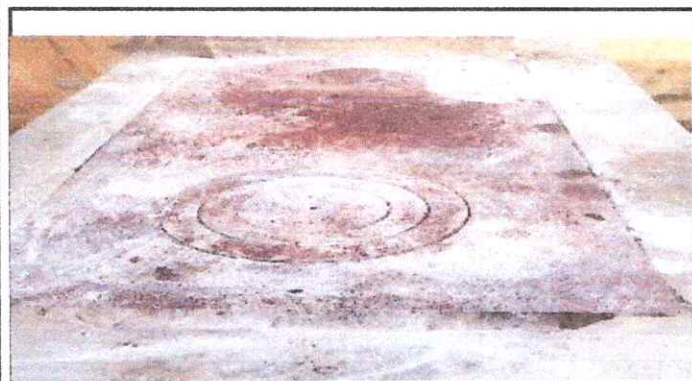
Foto 15: Sustrucción de plancha 3 hornillas
