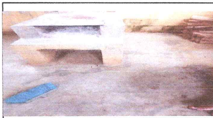
16.Reparación de azulejo en estufa rural
