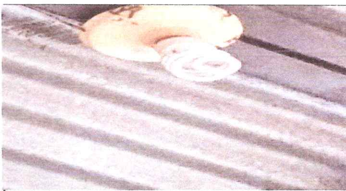
Foto 10: Sustitución de focos ahorradores
