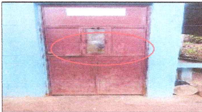
Foto 4: Mantenimiento de estructura de metal de puertas
