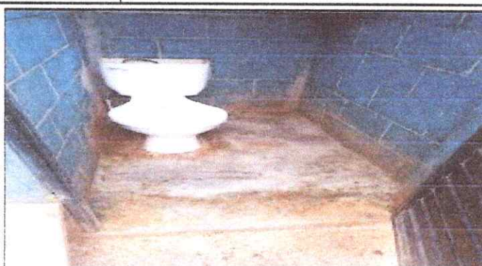
8. Sustitución de inodoro
