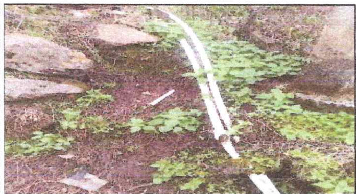
Foto 9: Sustitución de red general de drenaje
