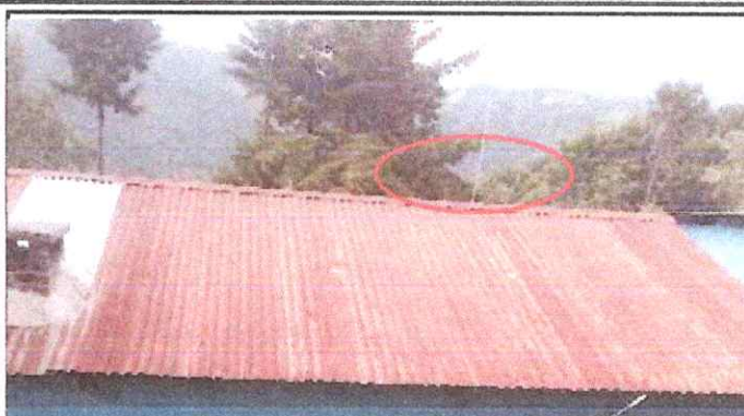
2. Sustitución de capote de lámina para lámina troquelada
