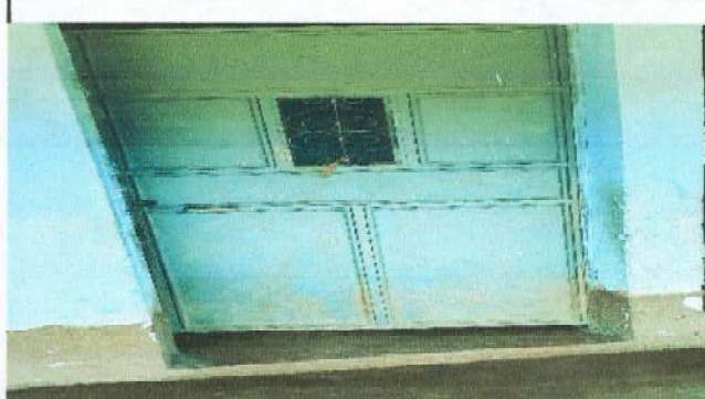
Foto 8: Mantenimiento en puertas
