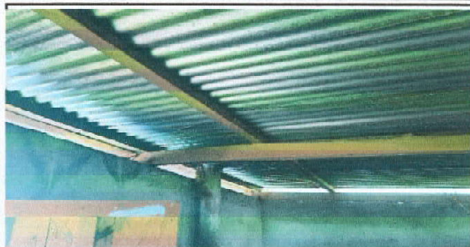
Foto 2: Sustitución de lámina por lámina
