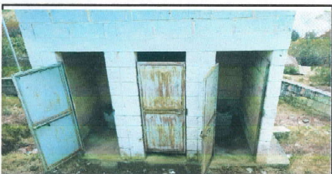
Foto 5: Sustitución de letrinas por baños lavables
