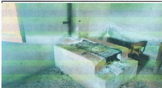
Foto1: Sustitución de estufa rural (pollo) y chimenea
