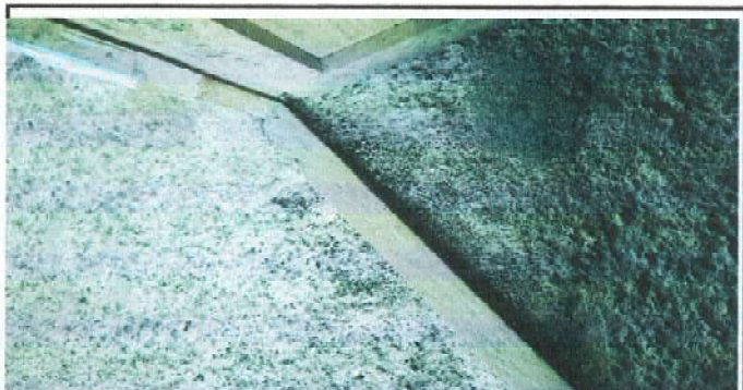
Foto 3: Sustitución de piso por torta de concreto
