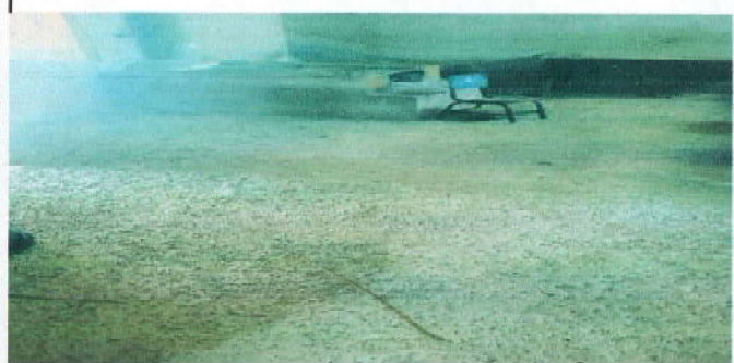
Foto 11: Sustitución de piso de torta
