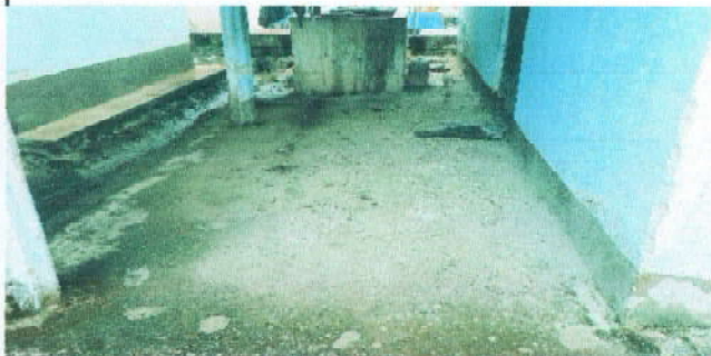
Foto 10: Sustitución de piso de torta
