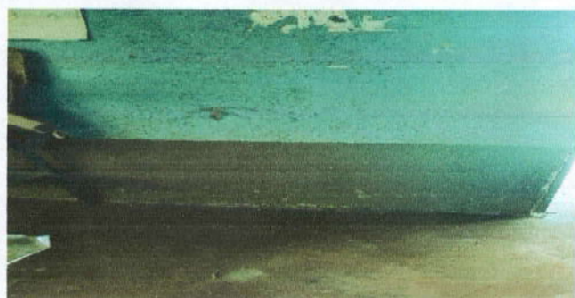
Foto7: Pintura en paredes interiores
