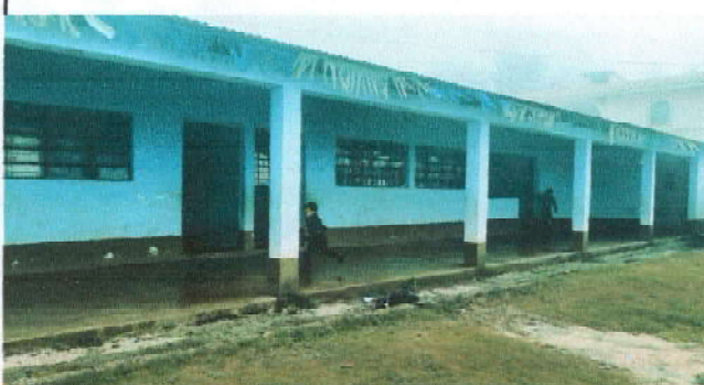
Foto 12: Sustitución de pintura
