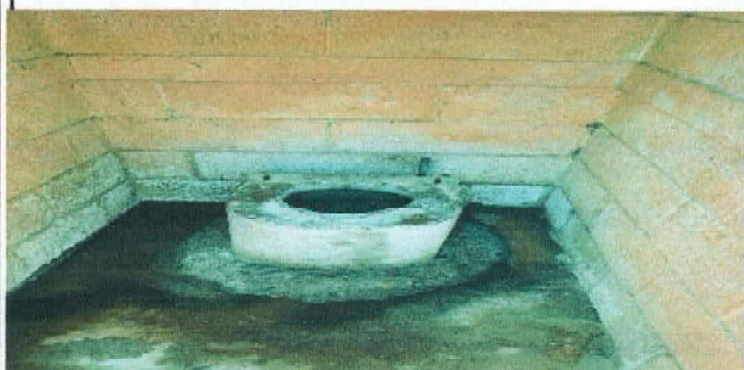
Foto 9: Sustitución de letrinas
