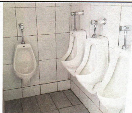
Foto 6: Sustitución de mingitorio
