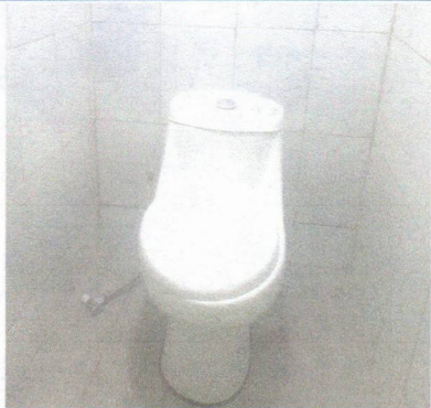
Foto 1: Sustitución de inodoros en mal estado
