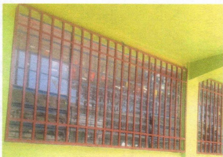
Foto 5: Mejoramiento de ventanas con balcones
