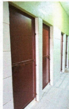
Foto 2: Sustitución de puerta en mal estado
