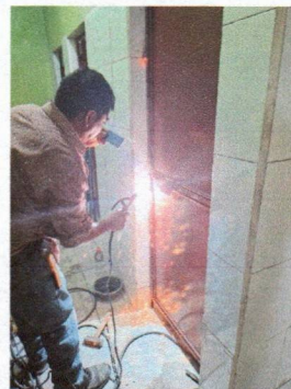
Foto 2: Sustitución de puerta en mal estado
