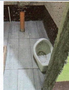
Foto 6: Sustitución de mingitorio
