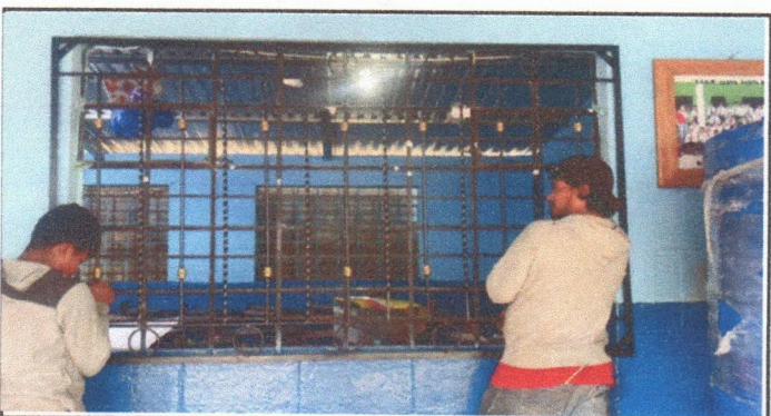
Foto 5: mantenimiento de balcones de metal ( lijado agregado, pintura y colocación)
