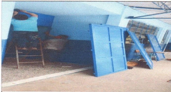
Foto 1: reparación de puertas (chapa, pintura y colocación)
