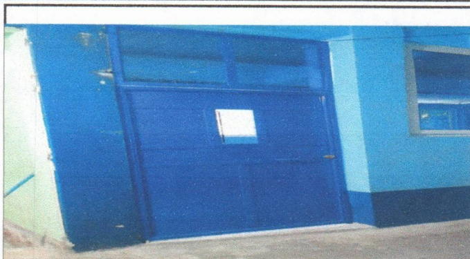
Foto 2: sustitución de puertas de metal
