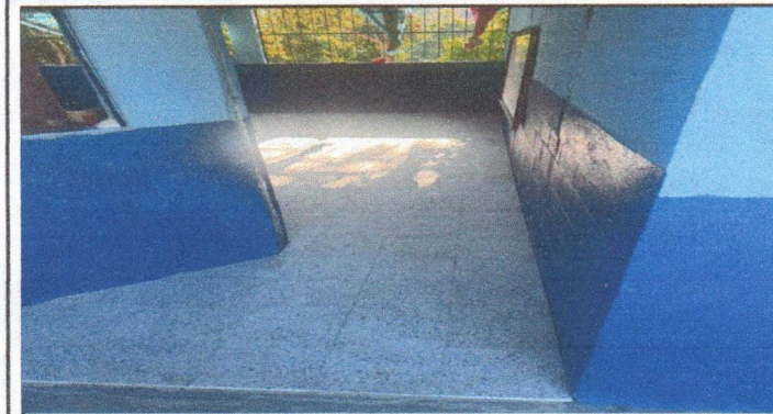
Foto1: sustitución piso de granito
