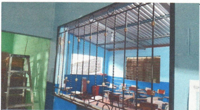
Foto 3: sustituciones de balcones de metal
