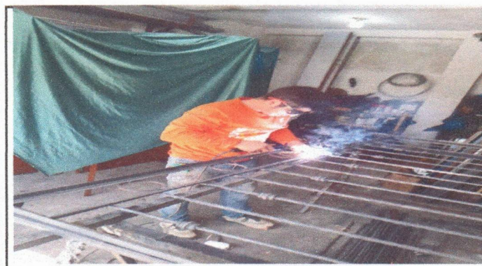
Foto 3: sustituciones de balcones de metal
