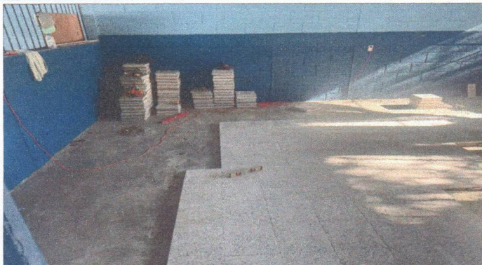
Foto1: sustitución de piso de granito
