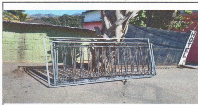
Foto 5: mantenimiento de balcones de metal ( lijado agregado, pintura y colación)
