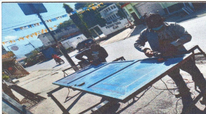
Foto1: reparación de puertas (chapa, pintura y colocación)
