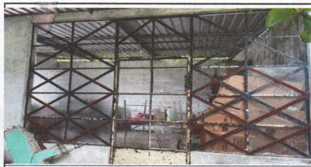
Foto 5: mantenimiento de valcones de metal (lijado agregado, pintura y colocación)
