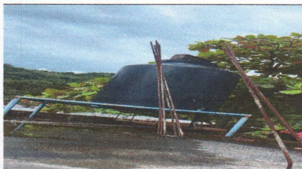
Foto 4: sustitución de tinaco
