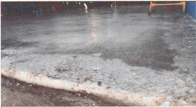
Foto1: sustitución de piso de granito
