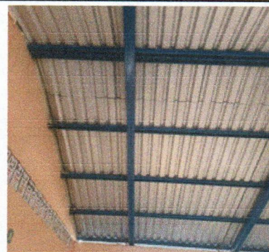
Foto 6: Sustitución de lamina por lamina troquelada aluzinK calibre 26
