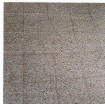
Foto 4: Sustitución de piso de granito
