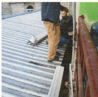
Foto 5: Canales y bajadas de agua pluvial
