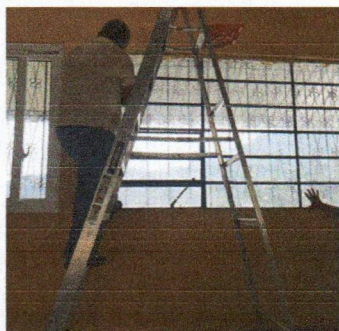
Foto 3: Sustitución de estructura de metal de ventana por ventana doble corrediza de UPVC COLOR BLANCO
