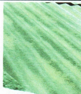
Foto 6: Sustitución de lámina por lámina troquelada aluzink calibre 26
