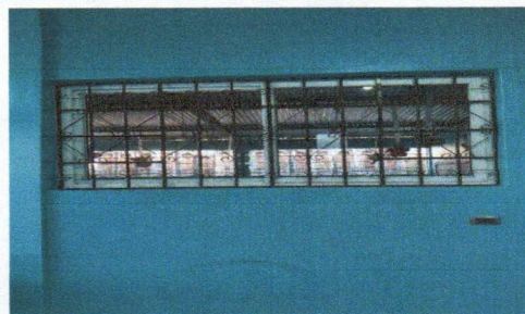
6. sustitucion de elementos de fijacion
