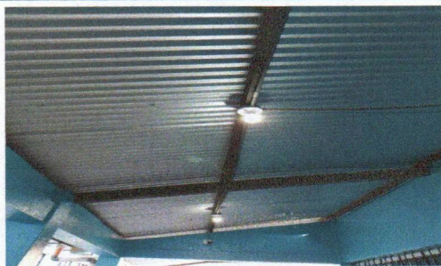
5. sustitucion de lamina por lamina troquelada aluzinc calibre 26
