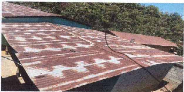
Foto 4: Sustitución de lámina, por lámina troquelada marca maxulum calibre 26
