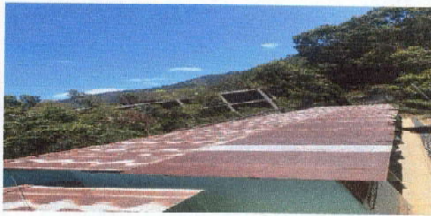
Foto1: Sustitución de lámina, por lámina troquelada marca maxulum calibre 26
