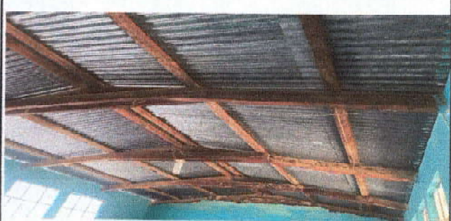
Foto 2: Sustitución de estructura de soporte de madera.
