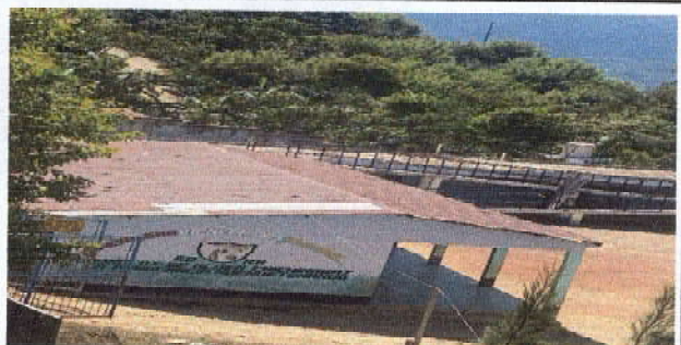
Foto 3: Sustitución de lámina, por lámina troquelada marca maxulum calibre 26
