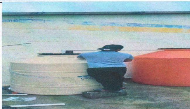
Foto 7: Sustitución de deposito de agua de 1100 litros
