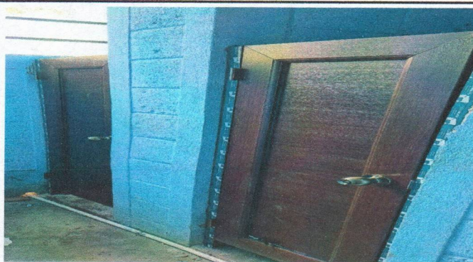
Foto 3: Servicios sanitarios, mejoramiento con puertas de UPVC de 60 cm. por 160 cm
