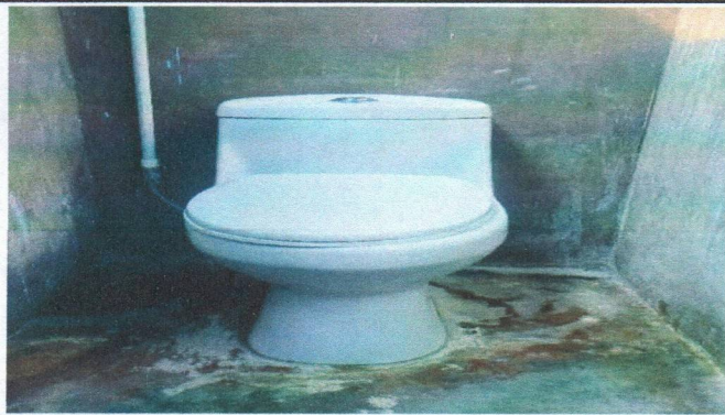
Foto1: Servicios sanitarios, sustitución de inodoros.
