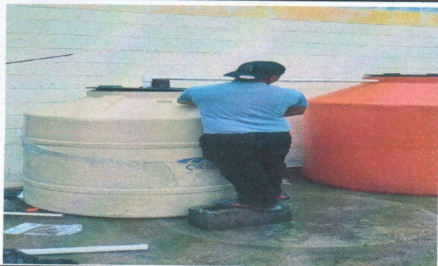
Foto 7: Sustitución de deposito de agua de 1100 litros
