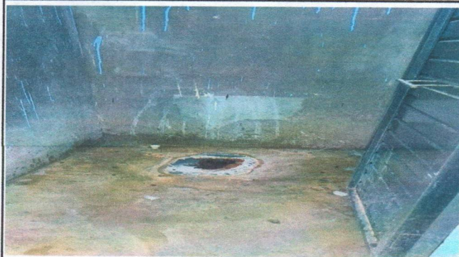
Foto 1: Servicios sanitarios, sustitución de inodoros.
