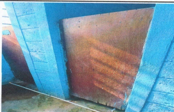
Foto 3: Servicios sanitarios, mejoramiento con puertas de UPVC de 60 cm. por 160 cm
