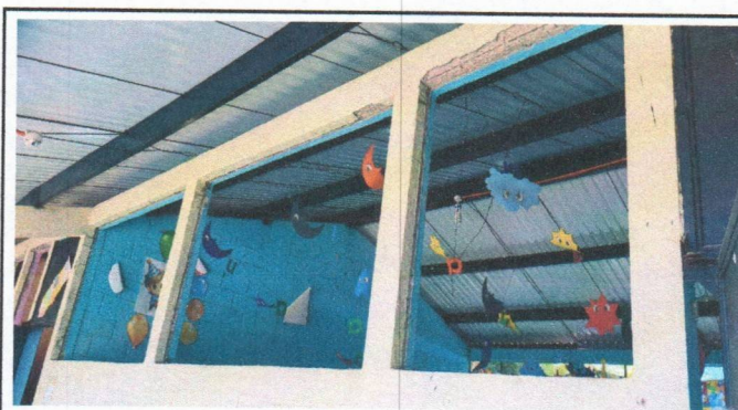
Foto 4: Ventanas, sustitución de estructura de metal por estructura de UVPC más vidrios
