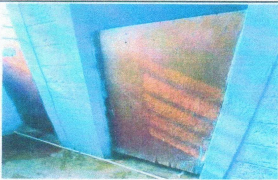
Foto 3: Servicios sanitarios, mejoramiento con puertas de metal de 60 cm. por 160 cm
