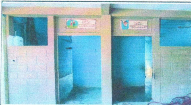
Foto 9: Mejoramiento con puertas de metal de 102 cm. por 208 cm. en servicio sanitario
