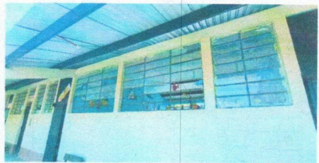
Foto 4: Ventanas, sustitución de estructura de metal por estructura de UVPC más vidrios
