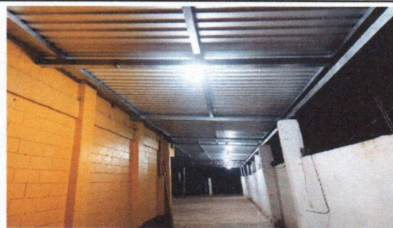
FOTO No. 4 VISTA DEL PASILLO DEL SALÓN
