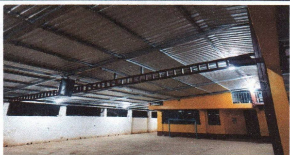
FOTO No. 3 VISTA DE TECHO NUEVO
