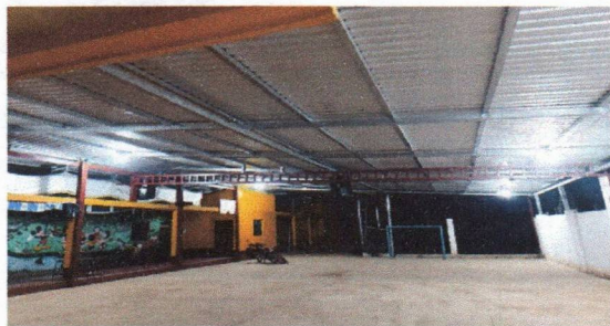
FOTO No. 1 SUSTITUCION DE LAMINA
