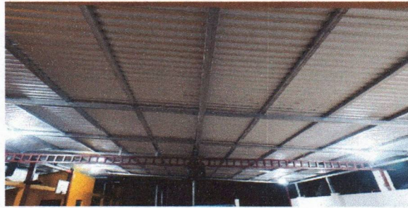
FOTO No. 2 SUSTITUCION DE ESTRUCTURA DE SOPORTE
