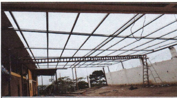
FOTO No. 5 YA INSTALADAS LA COSTANERAS PARA LA COLOCACIÓN DE LAS LAMINAS.
