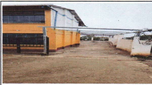
FOTO No. 4 INICIO DE LAS COLOCACIONES DE NUEVAS COSTANERAS.
